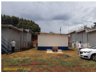
Foto 1 - Vista geral da ETE.
