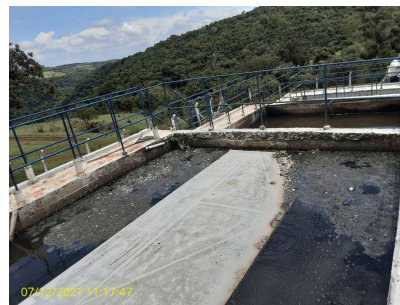
Foto 2 - Vista 1 dos tanques.
