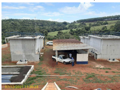
Foto 5 - Vista geral da ETE (lado oposto).
