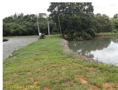
Foto 6 - Passagem entre segunda e terceira lagoas anaeróbias.
