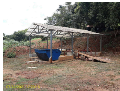
Foto 2 - Depósito provisório de lodo.
