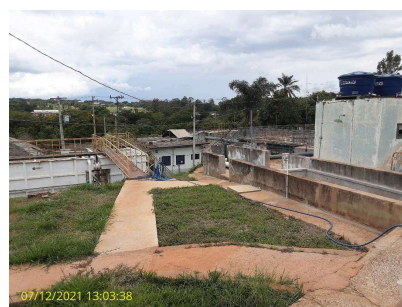
Foto 4 - Vista geral da ETA Convencional.
