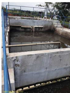
Foto 3 - Vista 2 dos tanques.
