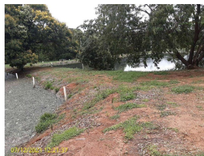
Foto 4 - Vista da passagem entre lagoas anaeróbias.
