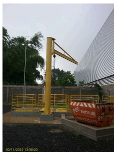
Foto 1 - Vista geral da unidade
