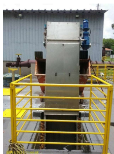
Foto 13 - Gradeamento grosseiro - novo
