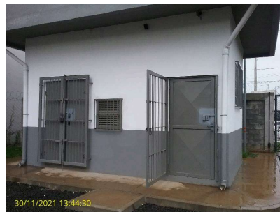
Foto 4 - Sala de painéis
