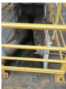
Foto 5 - Aplicação de Alcalinizante
