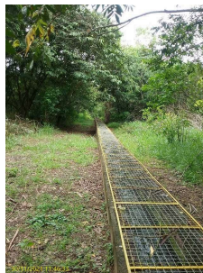
Foto 15 - Saída do efluente tratado
