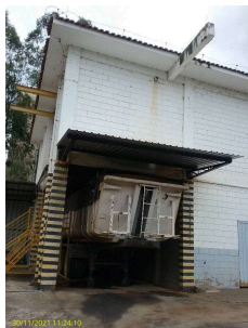
Foto 9 - Desidratação do lodo - encaminhado ao Estre em Paulínia
