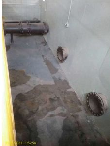
Foto 18 - Sala de desinfecção
