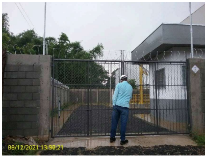
Foto 1 - Portão de acesso
