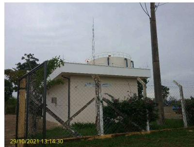
Foto 2 - Vista do reservatório Flora
