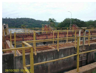
Foto 4 - Vista do desarenador
