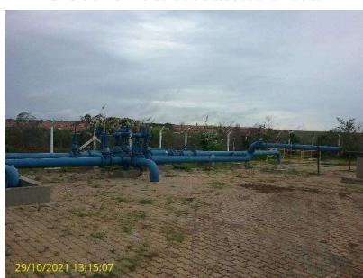
Foto 3 - Poço Flora I desativado devido a produção de areia
