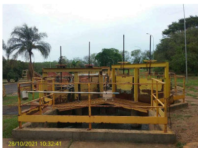
Foto 1 - Vista geral do tratamento preliminar
