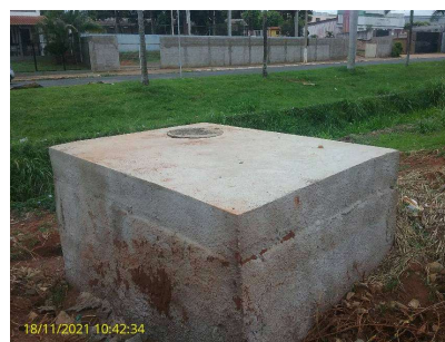
Foto 16 - Vista da caixa de passagem do interceptor
