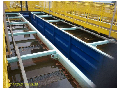
Foto 2 - Vista dos vertedores
