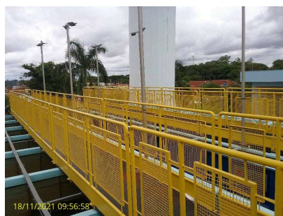
Foto 1 - Vista dos guarda-corpo da ETA
