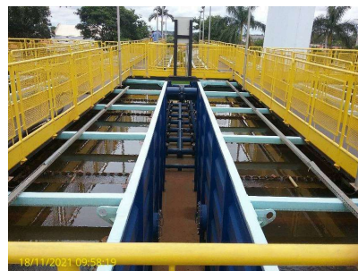
Foto 6 - Vista dos filtros
