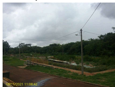
Foto 6 - Vista dos digestores anaeróbios de fluxo ascendente -DAFA
