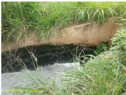
Foto 14 - Saída esgoto da lagoa
