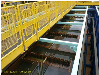
Foto 1 - Vista dos vertedores
