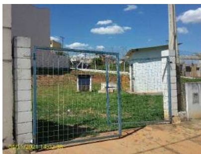
Foto 1 - Portão de acesso à elevatória
