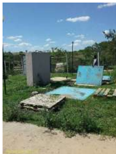
Foto 1 - Aspecto geral da elevatória
