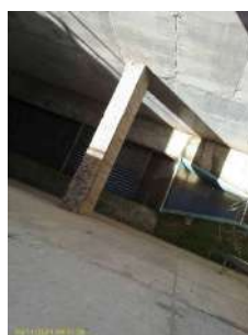
Foto 2 - Detalhe do gradeamento
