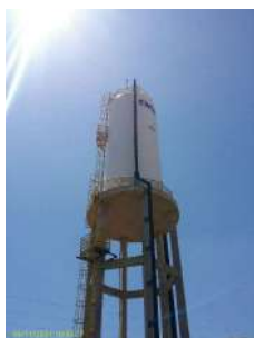
Foto 1 - Aspecto geral do reservatório
