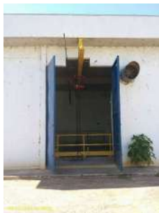
Foto 7 - Portão de acesso aos conjuntos motobomba
