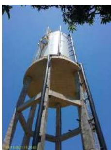
Foto 1 - Aspecto geral do reservatório
