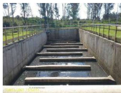
Foto 23 - Tanque de contato após desinfecção
