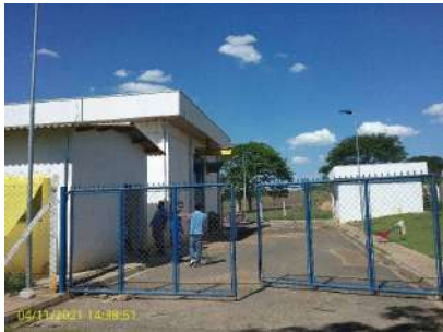
Foto 1 - Portão de acesso à elevatória
