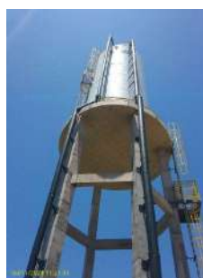
Foto 2 - Detalhe da escada de acesso com guarda-corpo à direita
