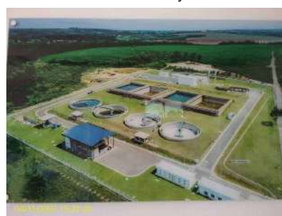
Foto 8 - Vista aérea da ETE (quadro)
