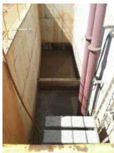
Foto 6 - Poço de sucção de esgoto
