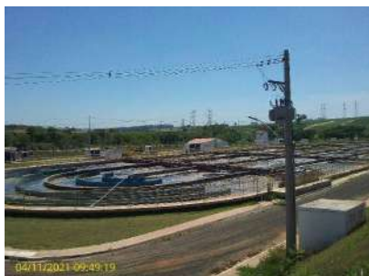
Foto 18 - Sistema de tratamento do tipo valo de oxidação
