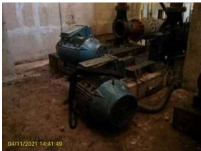
Foto 3 - Conjuntos motobomba retirados para manutenção
