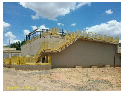
Foto 6 - Tratamento físico químico com cloreto férrico
