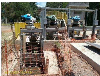
Foto 4 - Construção de um novo canal para a peneira rotativa reserva
