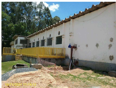
Foto 1 - Casa de bombas
