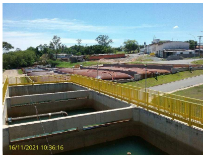
Foto 2 - Estação de tratamento de lodo, com geobags
