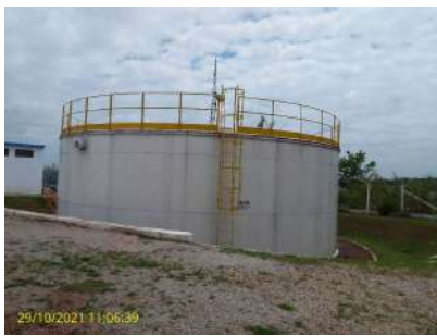
Foto 1 - Aspecto geral do reservatório em aço
