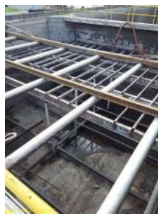
Foto 11 - Tanque em troca das tubulações de aeração
