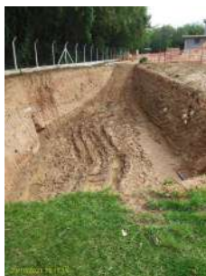
Foto 5 - Área de futuro desarenador
