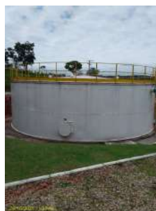
Foto 2 - Reservatório de 500 m3, em vaso comunicante com o R2
