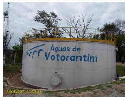
Foto 2 - Aspecto geral do reservatório em aço
