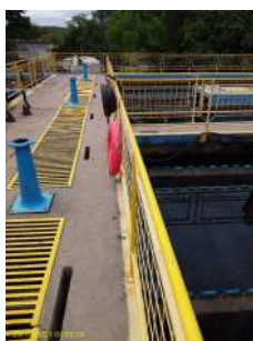
Foto 1 - Guarda corpos existentes
