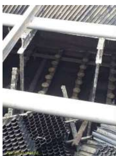
Foto 12 - Aeradores em substituição
