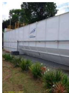
Foto 8 - Lateral do decantador
