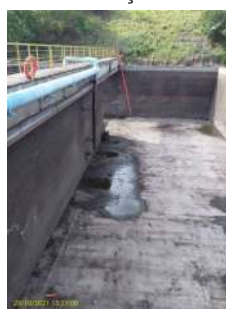
Foto 13 - Tanque em manutenção
