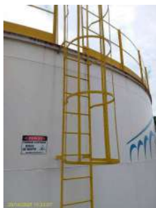
Foto 1 - Escada de acesso do reservatório em aço 500 m3
