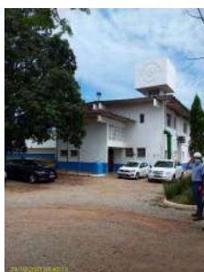
Foto 1 - Aspecto geral da ETA
