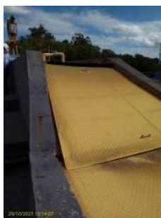
Foto 7 - Área da Calha Parshall (confinada)
