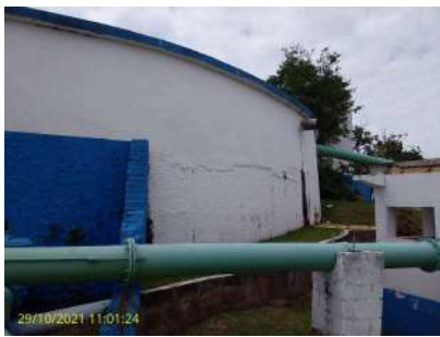
Foto 1 - Aspecto geral do reservatório
