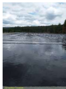
Foto 7 - Lagoa aerada com zona de decantação ao fundo
