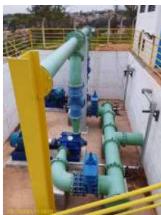
Foto 3 - Nova elevatória para Vila Irineu
