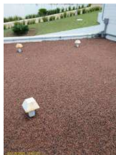
Foto 3 - Laje de cobertura e tubulações de ventilação
