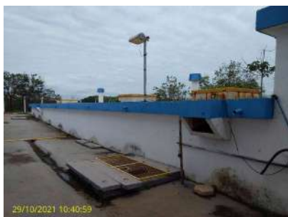
Foto 1 - Aspecto geral do reservatório
