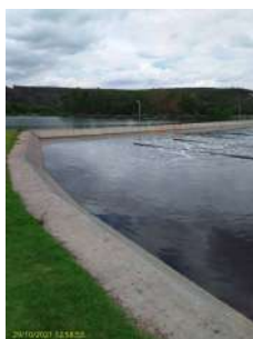
Foto 6 - Lagoa aerada e alteamento realizado
