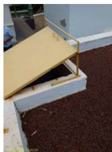
Foto 2 - Tampa de inspeção
