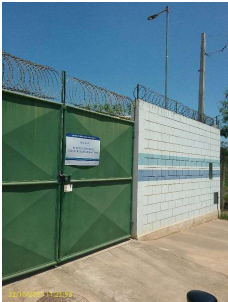
Foto 1 - Vista geral da EEEB
