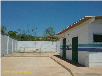
Foto 2 - Interior do local
