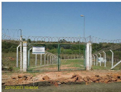
Foto 1 - Vista geral da EEEB
