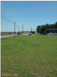
Foto 1 - Local da EEEB, também chamada de SUB.
