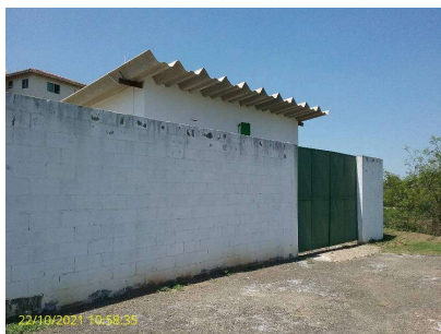
Foto 1 - Vista geral da EEEB
