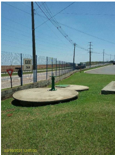
Foto 2 - Vista geral da EEEB. Subterrânea
