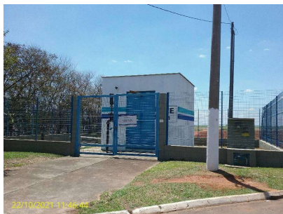
Foto 1 - Vista geral da EEEB
