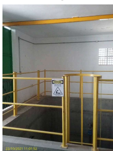
Foto 3 - Interior do local
