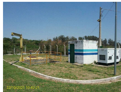
Foto 2 - Interior do local
