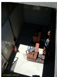
Foto 3 - Vista do interior
