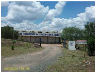
Foto 1 - Entrada da ETE
