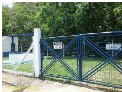
Foto 1 - Vista geral da EEEB
