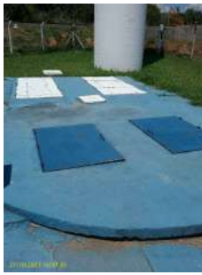
Foto 3 - Interior do local
