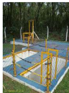
Foto 2 - Interior do local
