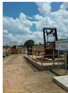
Foto 2 - Gradeamento mecânico em estado avançado de oxidação
