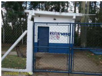
Foto 1 - Vista geral da EEEB
