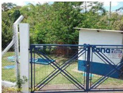
Foto 1 - Vista geral da EEEB
