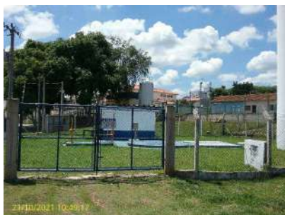
Foto 1 - Vista geral da EEEB
