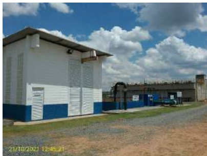
Foto 3 - Sala de sopradores
