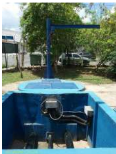
Foto 3 - Interior do local
