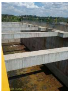
Foto 5 - Estrutura do segundo tanque de lodos ativados, para futura expansão.
