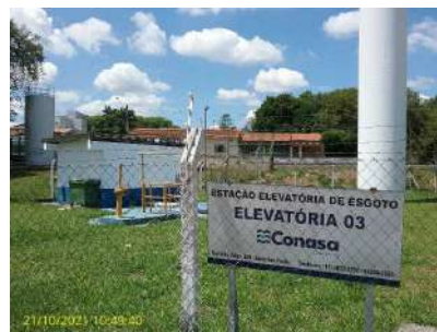
Foto 2 - Vista geral da EEEB
