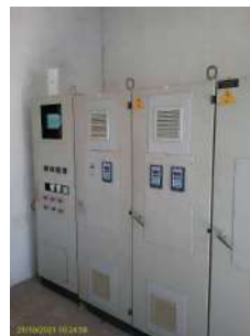
Foto 2 - Painel elétrico
