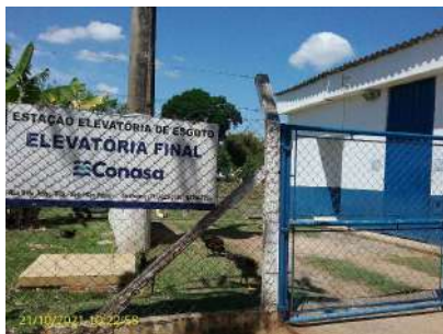
Foto 1 - Vista geral da EEEB
