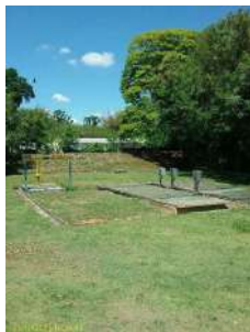
Foto 3 - Interior da área da EEEB
