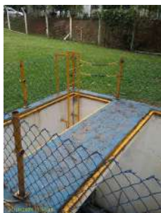
Foto 1 - Colocar guarda corpo
