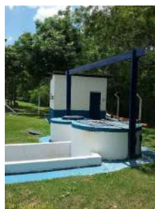
Foto 2 - Interior do local
