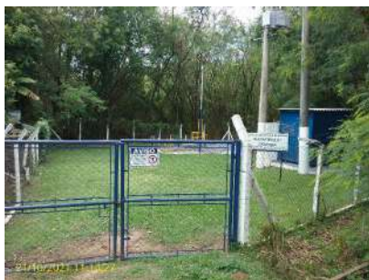
Foto 1 - Vista geral da EEEB
