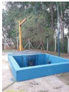
Foto 2 - Interior do local
