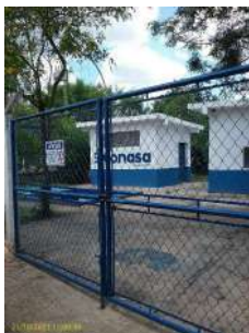
Foto 1 - Vista geral da EEEB
