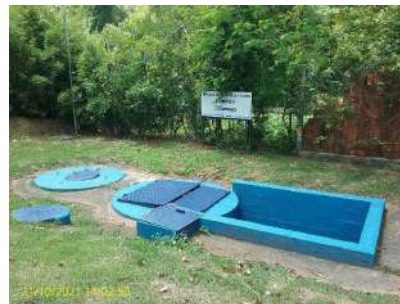
Foto 2 - Interior do local
