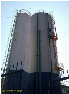
Foto 1 - Antigo reservatório à esquerda e novo reservatório à direita
