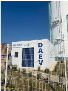
Foto 1 - Cercamento da elevatória e do reservatório
