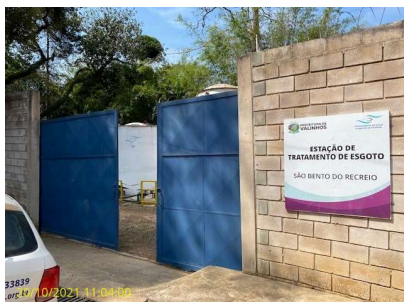
Foto 1 - Portão de acesso à ETE
