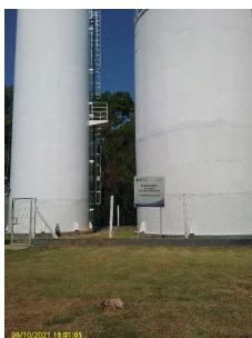
Foto 1 - Placa de identificação da área
