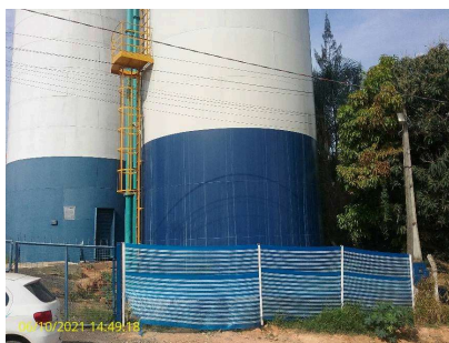
Foto 1 - Cercamento provisório do reservatório
