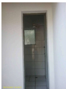
Foto 7 - Banheiro com chuveiro, que pode ser utilizado em emergências
