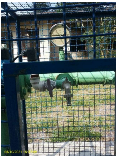
Foto 1 - Torneira para coleta de água
