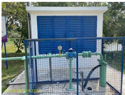
Foto 1 - Laje de proteção do poço P4
