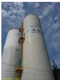
Foto 1 - Resevatórios São Bento do Recreio (novo à frente e antigo ao fundo)
