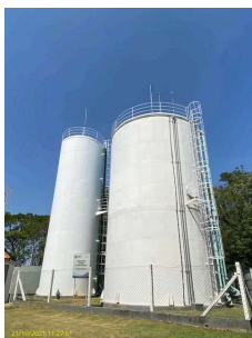
Foto 1 - Cercamento da área do reservatório
