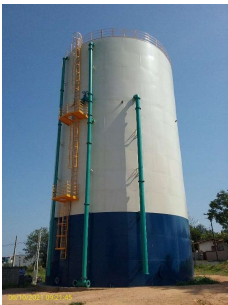
Foto 2 - Aspecto geral do reservatório
