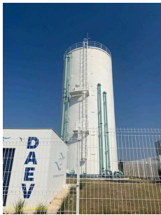
Foto 1 - Pára-raio no topo do reservatório
