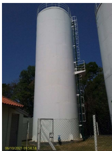
Foto 1 - Aspecto geral do reservatório
