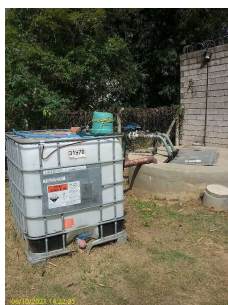
Foto 10 - Tanque de cloro para desinfecção
