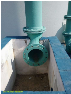
Foto 1 - Extravasor do reservatório
