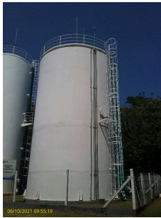
Foto 1 - Aspecto geral do reservatório e pára-raio na cobertura
