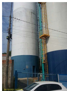
Foto 2 - Portão de acesso ao reservatório
