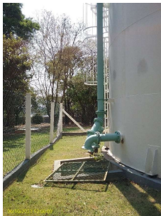
Foto 3 - Saída do extravasor e descarga de fundo
