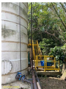
Foto 1 - Escada e guarda-corpo de acesso aos tanques de aeração
