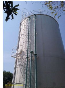
Foto 2 - Escada de acesso à cobertura e guarda-corpo
