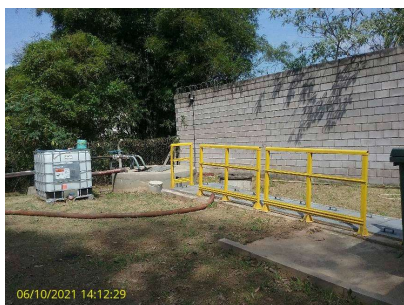
Foto 1 - Entrada do esgoto e desarenador
