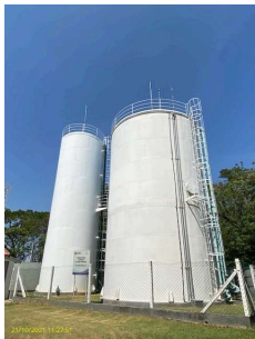
Foto 1 - Guarda-corpo na escada e cobertura do reservatório
