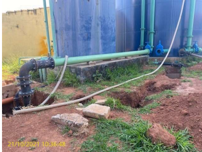
Foto 1 - Escavação no solo para interlição do reservatório ao sistema de distribuição de água
