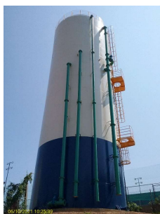
Foto 1 - Aspecto geral do reservatório
