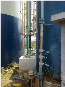
Foto 1 - Pedacos de concreto dispostos no chão do local
