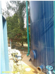
Foto 1 - Extravasor do reservatório
