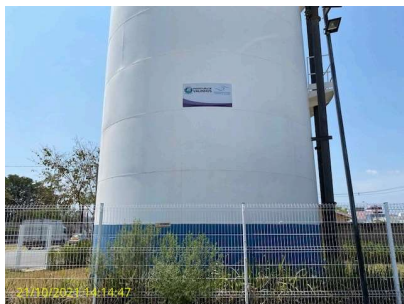
Foto 1 - Cercamento do reservatório
