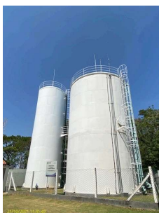
Foto 1 - Cercamento do reservatório
