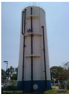
Foto 3 - Escada de acesso e guarda-corpo na cobertura
