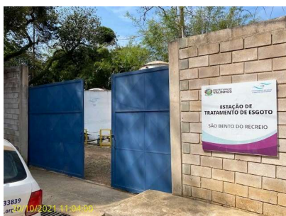
Foto 1 - Placa de Identificação da ETE
