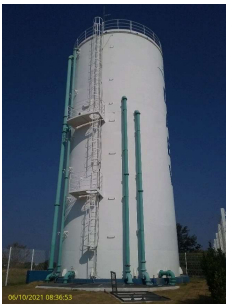
Foto 1 - Aspecto geral do reservatório
