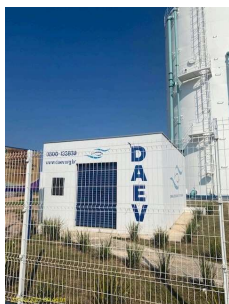
Foto 1 - Cercamento da elevatória e do reservatório
