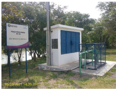
Foto 4 - Aspecto geral do poço
