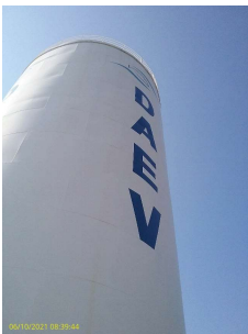
Foto 3 - Identificação do reservatório
