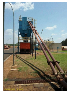
Foto 2 - Armazenamento do lodo após centrifugação
