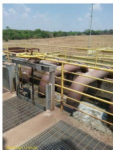
Foto 1 - Guarda-corpo no tratamento preliminar
