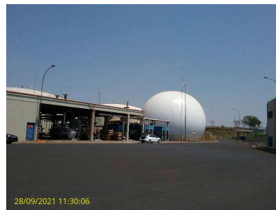
Foto 2 - Digestão do lodo com produção de energia elétrica
