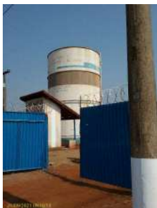
Foto 1 - Local do poço e reservatório 2
