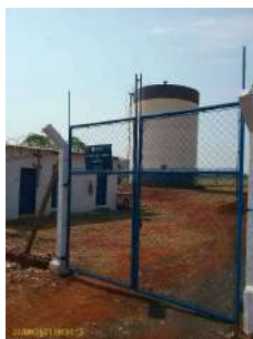
Foto 1 - Área do poço e reservatório 3
