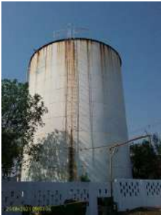
Foto 1 - Área do Reservatório Centro
