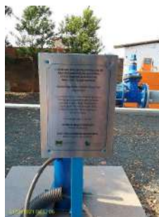
Foto 2 - Poço 1- Concessionária substituiu o poço antigo
