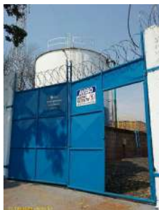
Foto 1 - Área do Reservatório e poço 4
