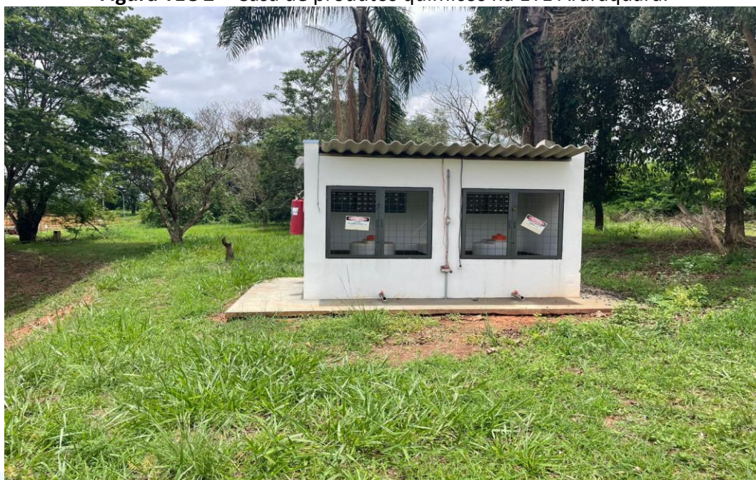
Figura TEC 2 – Casa de produtos químicos na ETE Araraquara.
