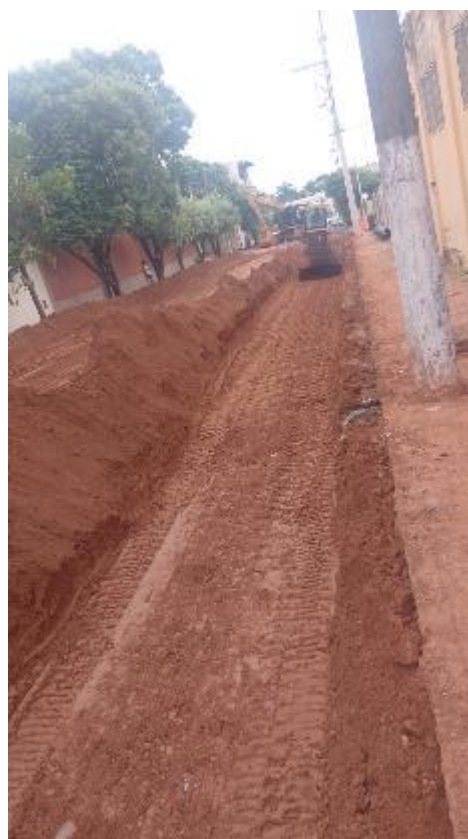
Figura 2 – Remanejamento de coletor tronco de esgoto
