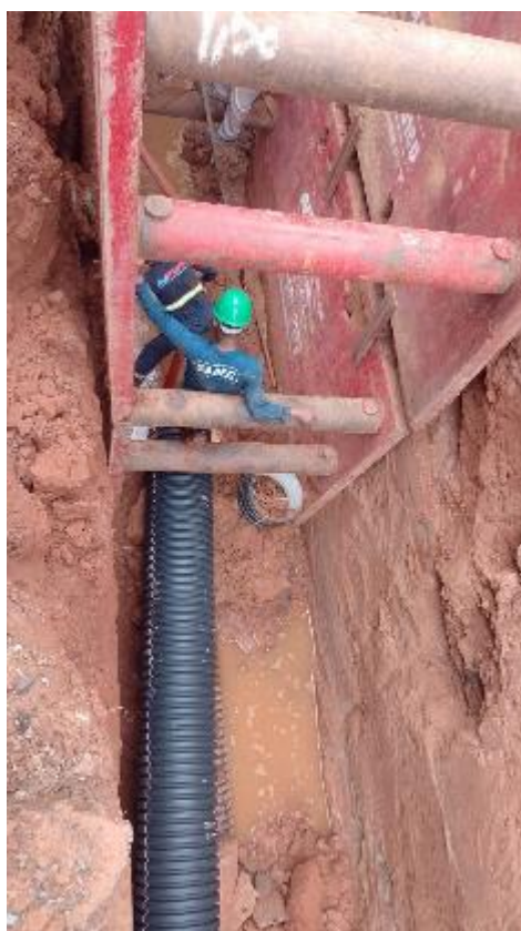
Figura 2 – Remanejamento de coletor tronco de esgoto
