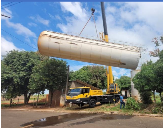
Foto 1 – Remoção do antigo Reservatório no Distrito Guarapuã (imagens do prestador).
