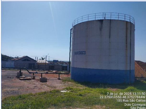
Foto 1 – Vista geral do ponto de perfuração do Poço Felipão. A tubulação que sai do poço está conectada diretamente ao Reservatório Felipão Novo (julho/25).
