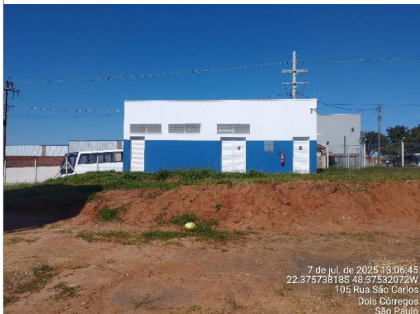
Foto 3 – Vista geral da edificação de apoio para abrigo dos equipamentos elétricos do poço (julho/25).
