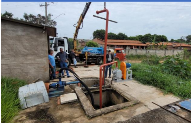
Foto 1 – Instalação da bomba na EEE Coimbra (imagens do prestador).
