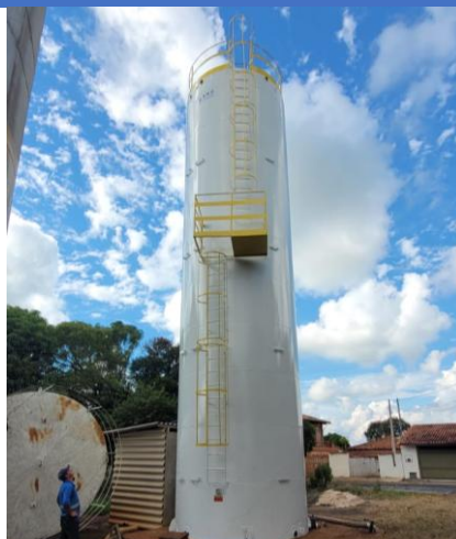
Foto 2 – Novo Reservatório de 100 m 3 instalado no Distrito Guarapuã (imagens do prestador).
