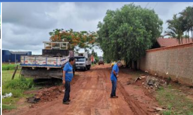
Foto 2 - Registro dos trabalhos de implantação das redes (imagens do prestador).
