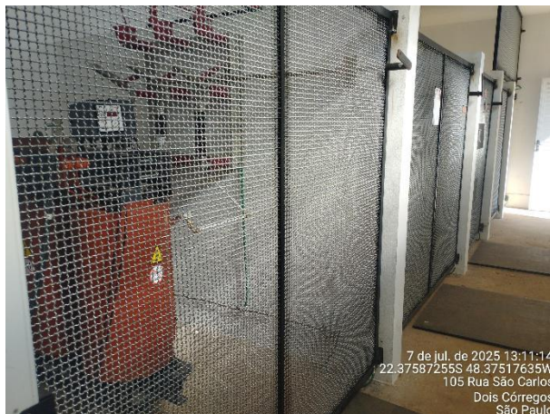
Foto 4 – Vista interna da edificação (julho/25).
