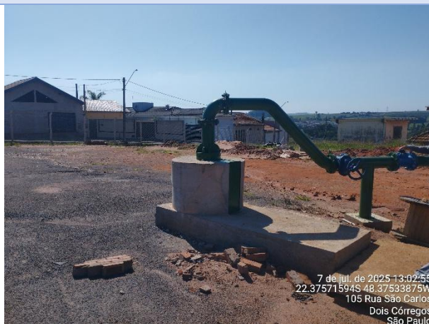
Foto 2 – Detalhe do ponto de perfuração do poço Felipão (julho/25).
