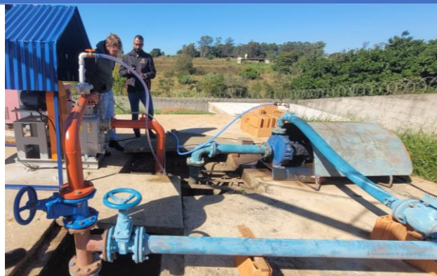
Foto 2 – Instalação da bomba na EEE Nicola Balivo (imagens do prestador).
