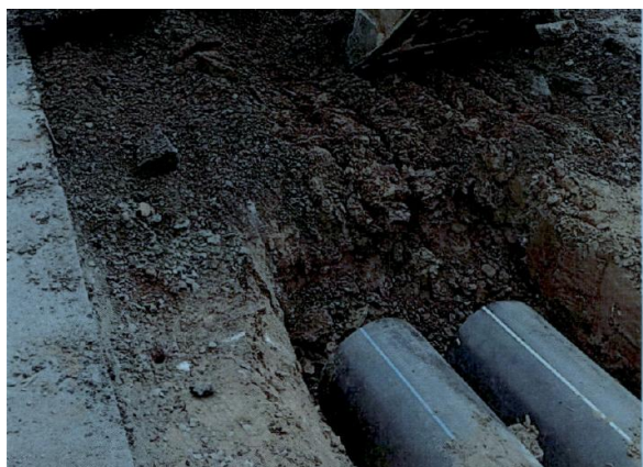
Figura TEC 6: Obras de interligação do sistema de esgotamento sanitário dos efluentes lançados na Av. José Antônio Migliato à montante da Rotatória da Av. Regit Arab - Cidade de Aracy (Fonte: SAAE)
