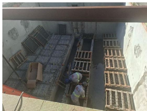
Figura TEC 19: Reforma filtro 2 da ETA Vila Pureza
