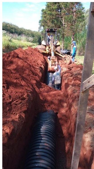
Figura TEC 7: Obras de substituição do emissário de esgoto do distrito de Água Vermelha - São Carlos/SP, trecho compreendido entre a Av. Bela Cintra até a ETE (Fonte: SAAE)
