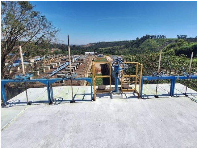
Figura TEC 9: Reforma caixa divisora ETE e UASB
