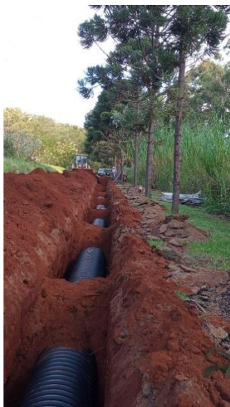
Figura TEC 7: Obras de substituição do emissário de esgoto do distrito de Água Vermelha - São Carlos/SP, trecho compreendido entre a Av. Bela Cintra até a ETE (Fonte: SAAE)
