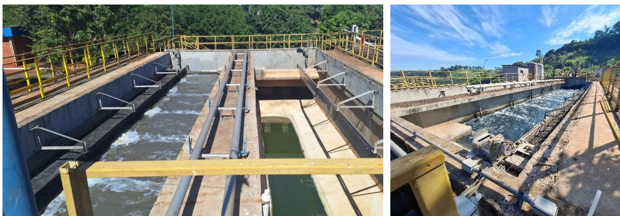
Figura TEC 4: Reforma do removedor de areia e gordura da ETE Monjolinho
