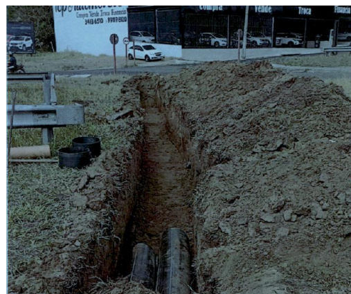
Figura TEC 6: Obras de interligação do sistema de esgotamento sanitário dos efluentes lançados na Av. José Antônio Migliato à montante da Rotatória da Av. Regit Arab - Cidade de Aracy (Fonte: SAAE)
