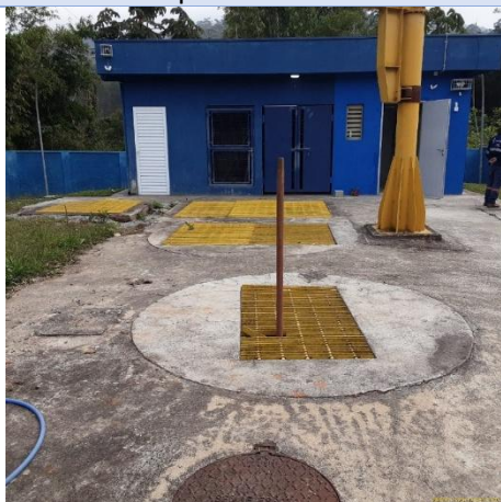
Foto 1 - EEE Botujuru I: Vista geral da elevatória após conclusão das melhorias.
