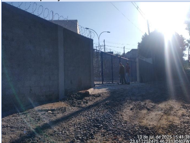
Foto 1 - EEE 4.1: Cercamento de área e portão de acesso à elevatória. Esta EEE está localizada em uma via sem nome, próximo à Rua Um
