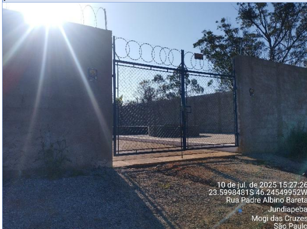
Foto 1 - EEE 1.1: Cercamento de área e portão de acesso à elevatória. Esta EEE está localizada em uma travessa da Rua Padre Albino Bareta.
