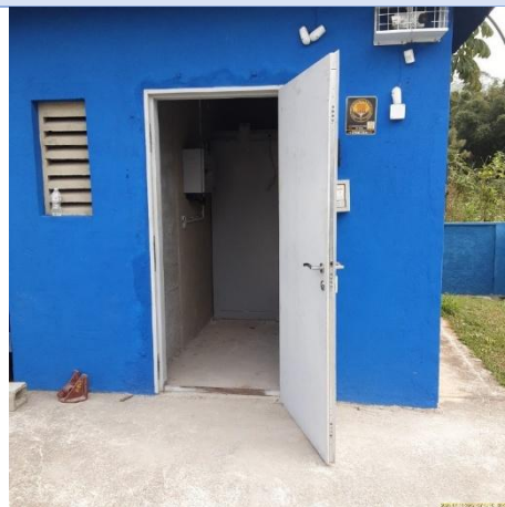
Foto 2 - EEE Botujuru I: Detalhe de alguns itens de segurança instalados, como porta antifurto, câmeras de segurança e alarmes.
