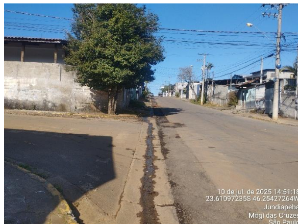
Foto 4 - Trecho de rede já implantada na Rua Hugo Torre.
