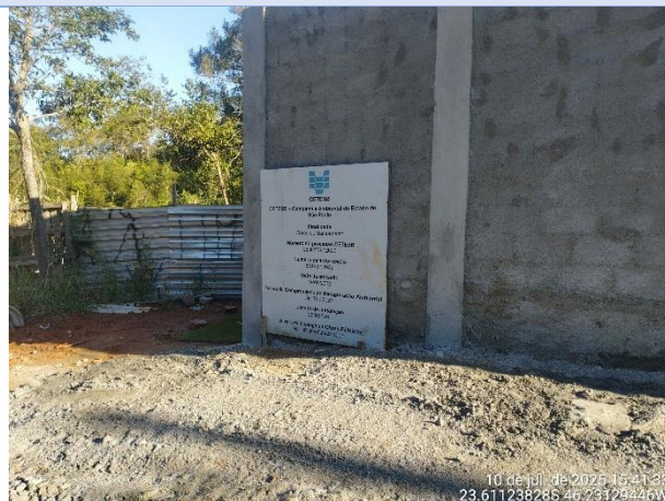
Foto 2 - EEE 4.1: Placa da CETESB de identificação da obra, afixada no muro de cercamento da elevatória.
