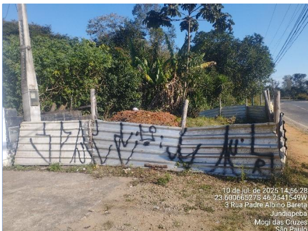
Foto 9 - EEE 2.2: Vista geral do local onde a EEE começou a ser construída. Após conclusão das tratativas para definição da faixa de domínio da SP-039, as obras serão retomadas.
