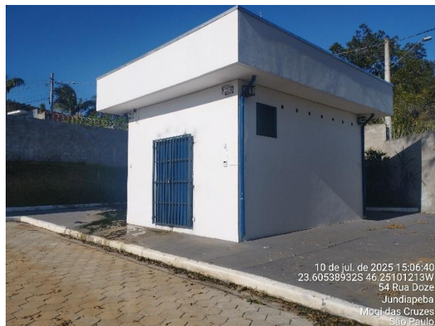
Foto 8 - EEE 2.1: Edificação para abrigo de equipamentos e painéis elétricos.
