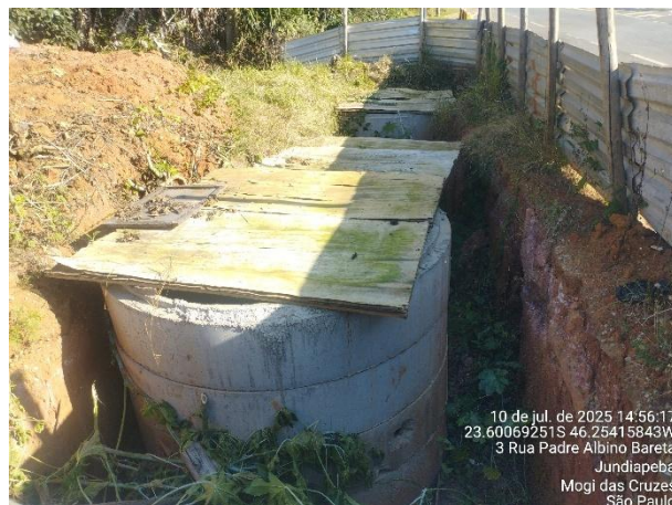
Foto 10 - EEE 2.2: Anéis de concreto instalados para execução da obra. A equipe aguarda a definição da faixa de domínio da SP-039 para realocação dessas estruturas e continuidade das obras.
