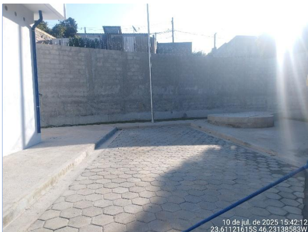
Foto 3 - EEE 4.1: Vista geral da elevatória.
