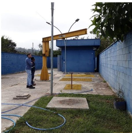
Foto 5 - EEE Botujuru IIA: Vista geral da elevatória após conclusão das melhorias.
