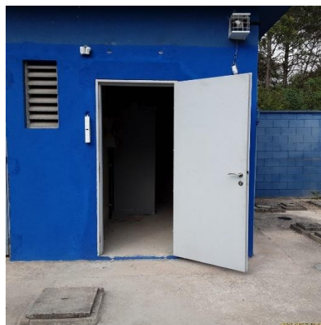
Foto 6 - EEE Botujuru IIA: Detalhe de alguns itens de segurança instalados, como porta antifurto, câmeras de segurança e alarmes.
