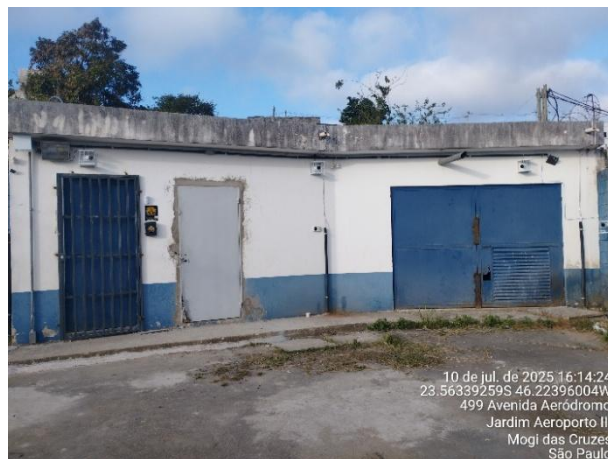
Foto 10 - EEE Oceania: Edificação que abriga os equipamentos elétricos da elevatória, com algumas melhorias já realizadas.
