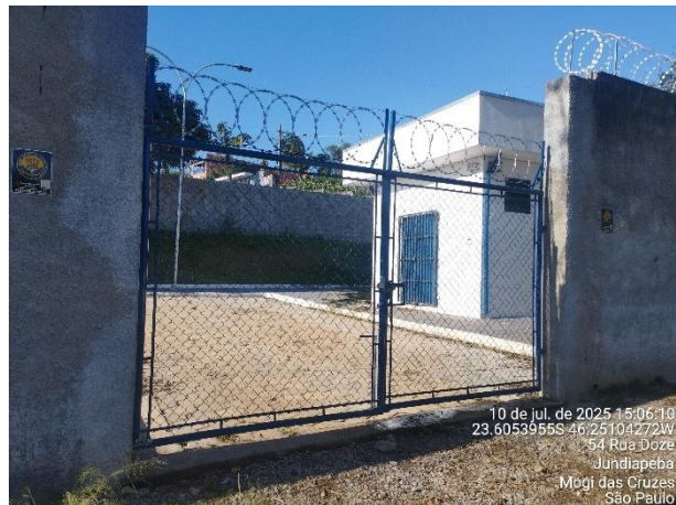
Foto 6 - EEE 2.1: Cercamento de área e portão de acesso à elevatória. Esta EEE está localizada na Rua Padre Albino Bareta, na altura do nº 1961-2397.
