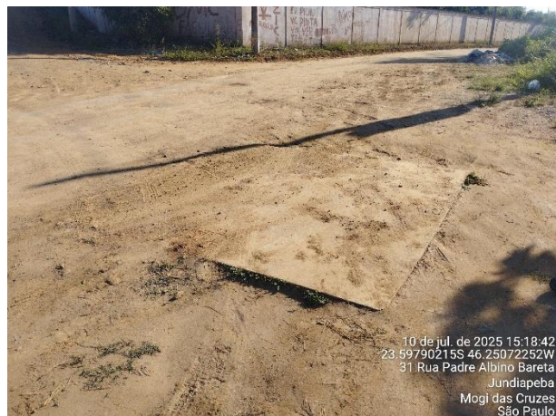
Foto 4 - EEE 1.2: Vista geral da elevatória instalada sob a Rua Padre Albino Bareta, na altura do nº 31.
