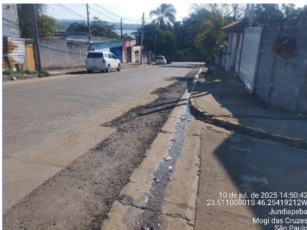
Foto 3 - Trecho de rede já implantada na Rua Hugo Torre.
