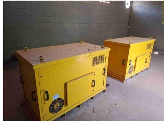
**Figura TEC 5 – Painéis de controle e sopradores da ETE Central.**
