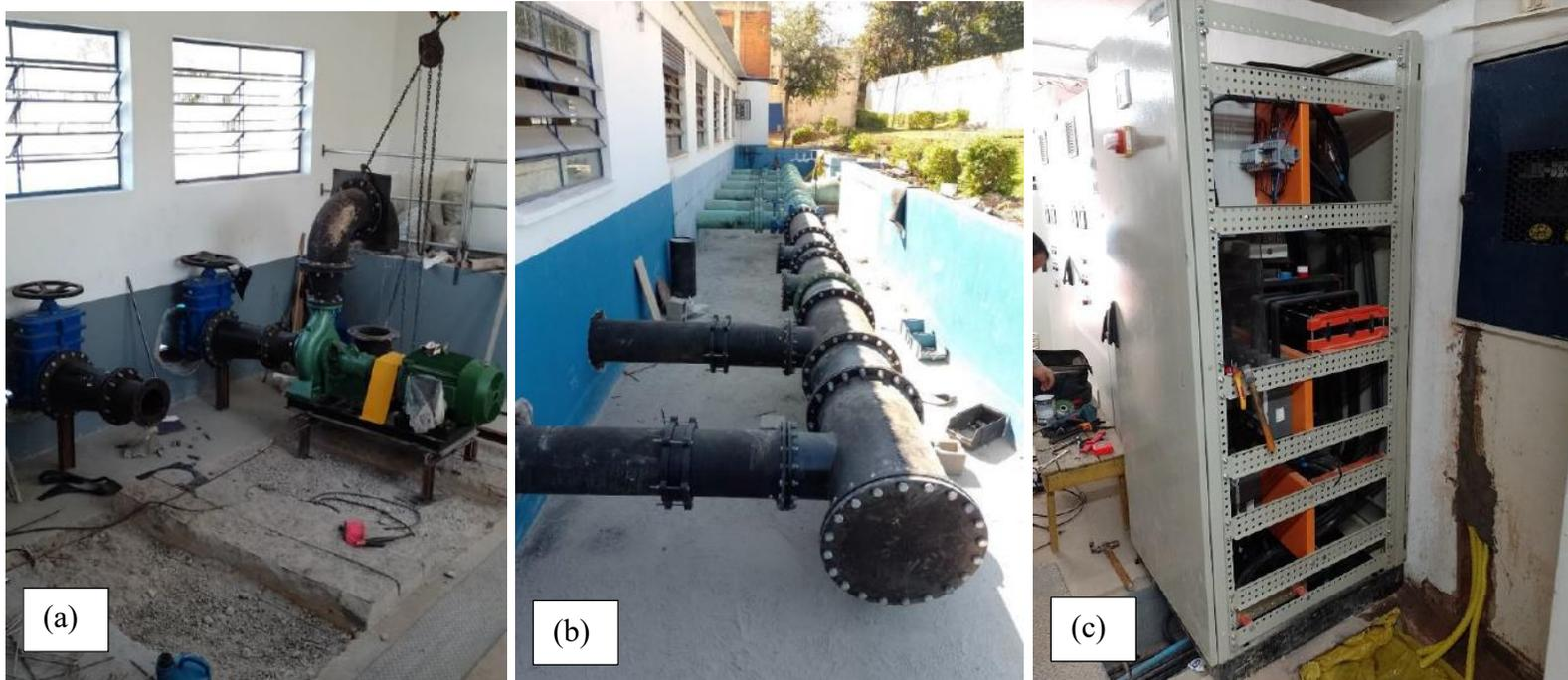
**Figura TEC 5** – Melhoria na EEAT Marechal – obras de melhoria civil, casa de bombas e equipamentos (itens 1 e 2 – Tabela TEC 9) – (a) ampliação de conjunto moto bomba; (b) barrilete de sucção; (c) ampliação de painel elétrico. FONTE: SEMAE.
