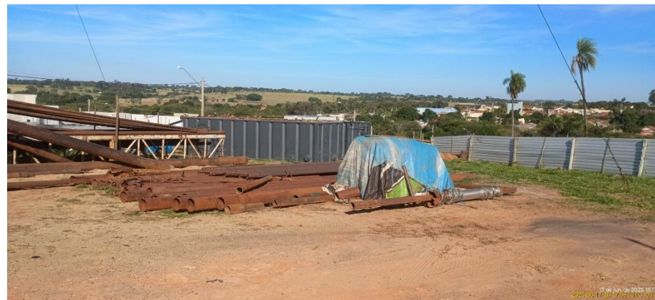
Foto 3 – Tubos removidos do poço até o momento da fiscalização.
