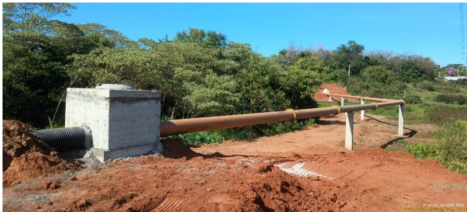
Foto 1 – PV e trecho do interceptor.
