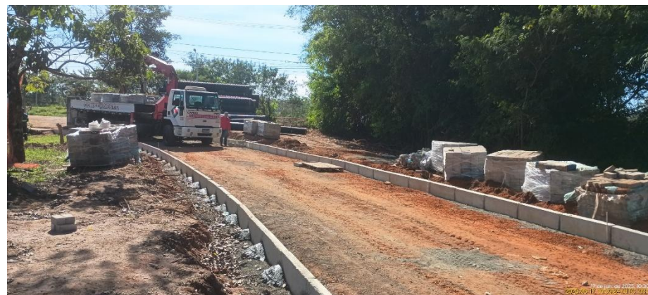
Foto 4 – Obras na EEE Porto de Areia referente à chegada do interceptor na estação.
