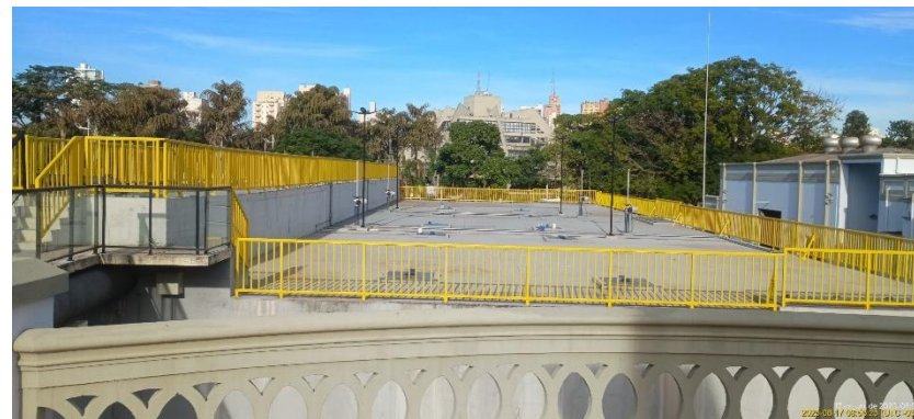
Foto 2 – Guarda-corpos instalados no reservatório de água tratada da ETA Palácio das Águas.
