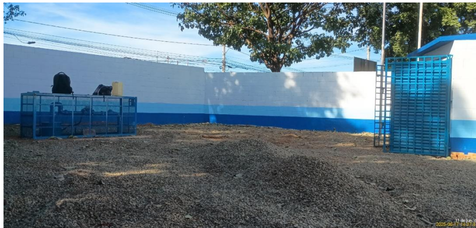
Foto 1 – Poço finalizado e protegido com gaiola.
