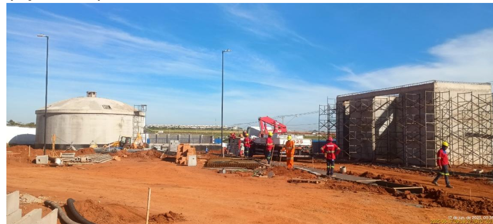
Foto 2 – Construção das demais estruturas na área operacional do PTG11.
