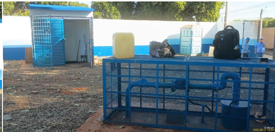
Foto 2 – Vista geral interna da área operacional do poço.
