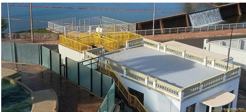
Foto 3 – Guarda-corpos instalados na chegada e elevatória de água bruta da ETA Palácio das Águas.
