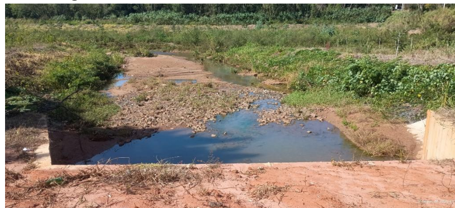
Foto 2 – Vista da área pós-desassoreamento nas margens do Córrego dos Macacos (esquina Av. Dr. Loft João Bassitt e Rua Benvido Mariano Mendes).
