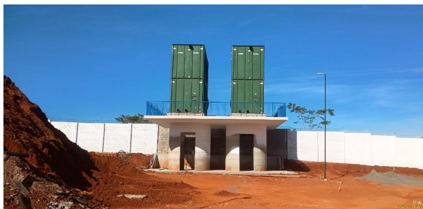
Foto 3 – Base e equipamentos para resfriamento da água captada no PTG11.
