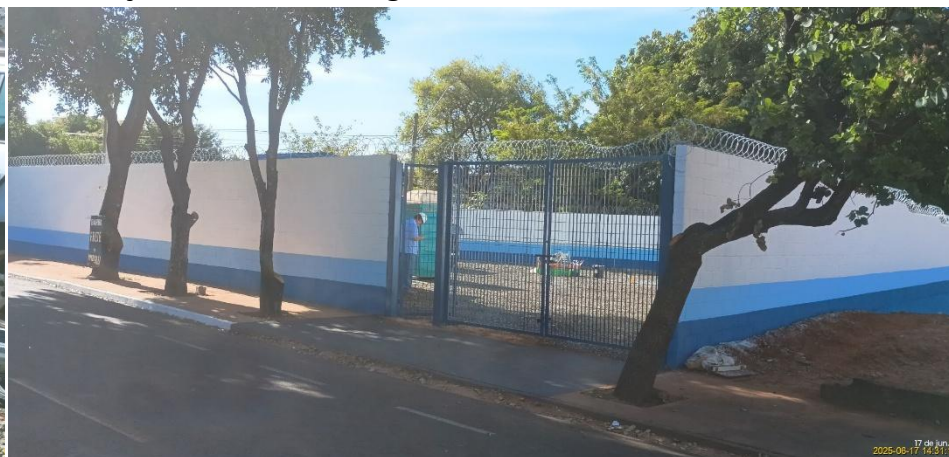
Foto 2 – Vista externa da área operacional do poço.
