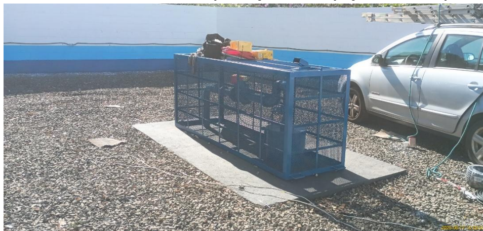
Foto 1 – Poço finalizado e protegido com gaiola.
