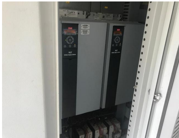
Figura TEC 12 – Conversores para painel (Bairro Santa Clara)
