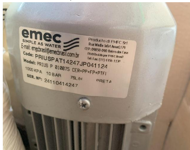
Figura TEC 15 – Bomba dosadora de sulfato para ETA
