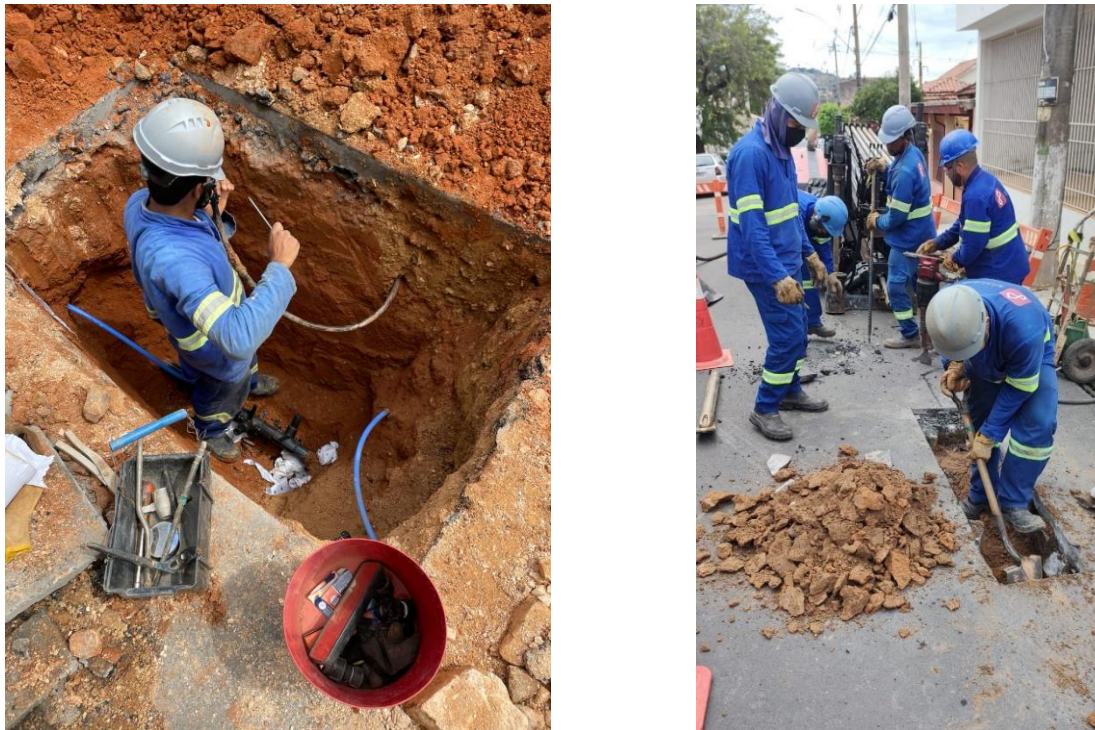
Figura TEC 5 – Substituição pelo Método Não Destrutivo das Redes de Distribuição de Água e Ramais de ligação dos Bairros Vila Macedo, Corcovado e Vila Santo Antônio
