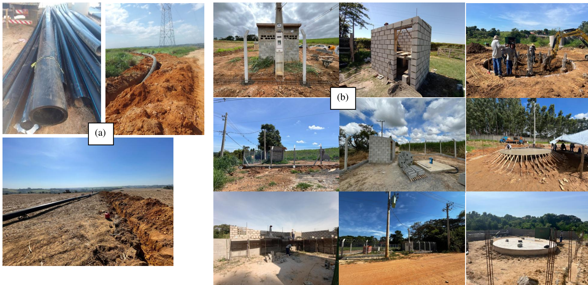
Figura TEC 5: (a) Aquisição de 1600m de tubos PEAD SDR17 PN10 PE100 de 110mm (Tabela TEC 15 – item 5); (b) Execução de obras de infraestrutura junto aos poços tubulares profundos (Tabela TEC 15 – item 14). FONTE: SAAE Porto Feliz.
