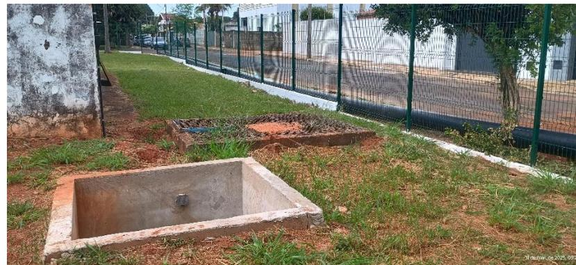
Foto 2 – Tubulações e caixa de passagem da nova adutora SA01.
