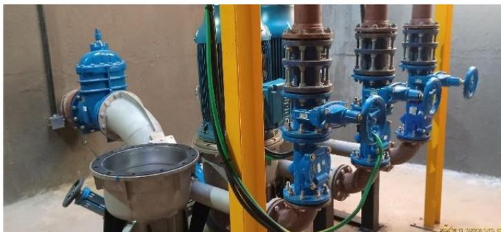
Foto 2 – Conjuntos motobomba instalados da EEE.
