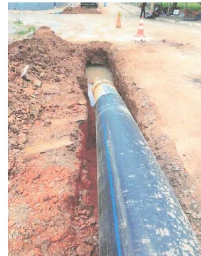
Foto 3 – Interligação da nova tubulação PEAD com adutora existente. Fonte: Relatório fotográfico Colínea, 2023.
