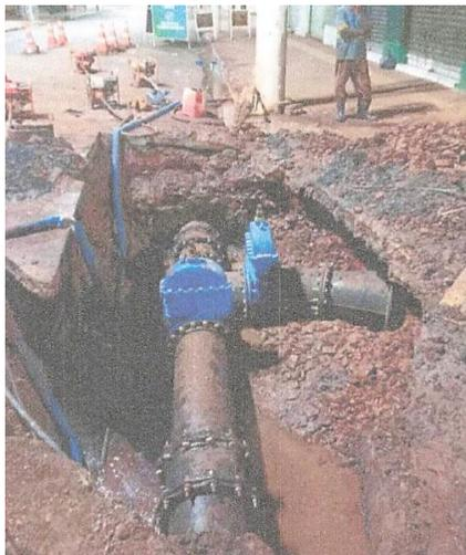
Foto 2 – Interligação da nova tubulação PEAD com adutora existente. Fonte: Relatório fotográfico Colínea, 2024.
