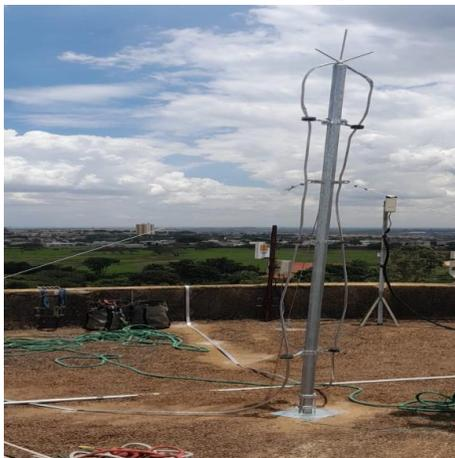
Foto 1 – Captor do SPDA na cobertura do reservatório elevado do CR13 Chácara Letônia. Fonte: Relatório fotográfico TopPower Engenharia, 2025.
