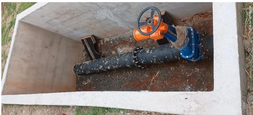
Foto 3 – Tubulações e caixa de passagem da nova adutora SA16.
