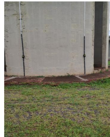
Foto 2 – Sistema de descida e caixas suspensas do SPDA do reservatório elevado do CR13 Chácara Letônia. Fonte: Relatório fotográfico TopPower Engenharia, 2025.
