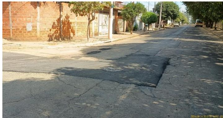
Foto 1 – Recapeamento no asfalto após a interligação da rede coletora com o novo coletor do sistema Balsa, em frente à EEE Jd. da Paz. Foto 2 – Recapeamento no asfalto após execução do novo coletor do sistema Balsa (Jd. da Paz).
