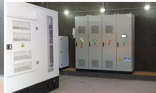
Foto 3 – Painel elétrico e de comando da EEE.
