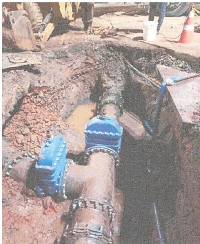
Foto 1 – Interligação da nova tubulação PEAD com adutora existente. Fonte: Relatório fotográfico Colínea, 2024.
