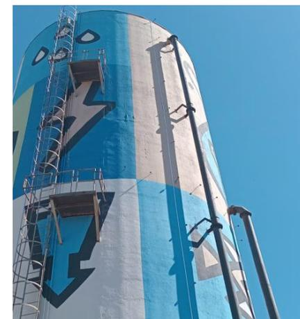
Foto 2 – Sistema de descida do SPDA do reservatório elevado do CR03 Santa Catarina. Fonte: Relatório fotográfico TopPower Engenharia, 2025.
