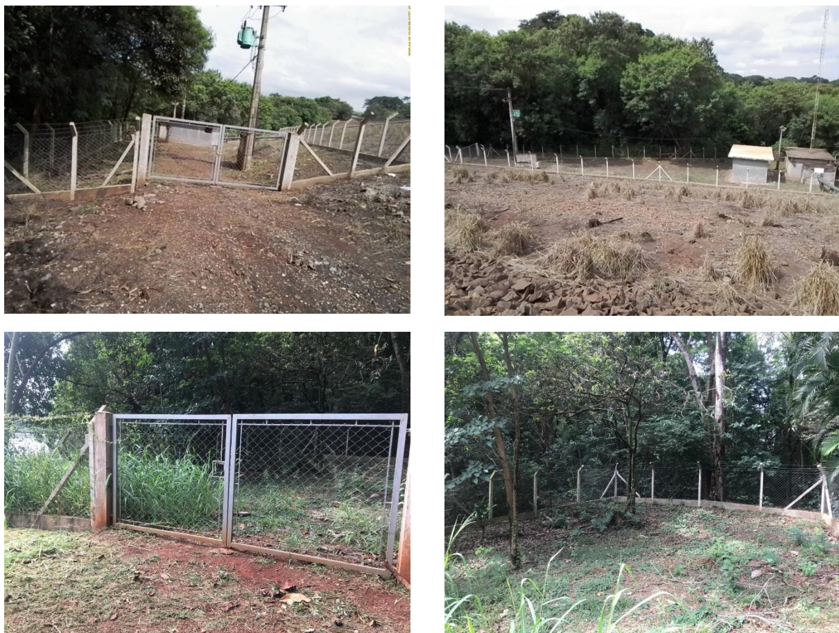
Figura TEC 3 – Instalação de alambrado nas estruturas de saneamento
