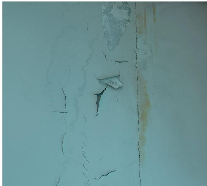
Exemplo dos pontos onde precisam de **Reparo de Junta de dilatação**
