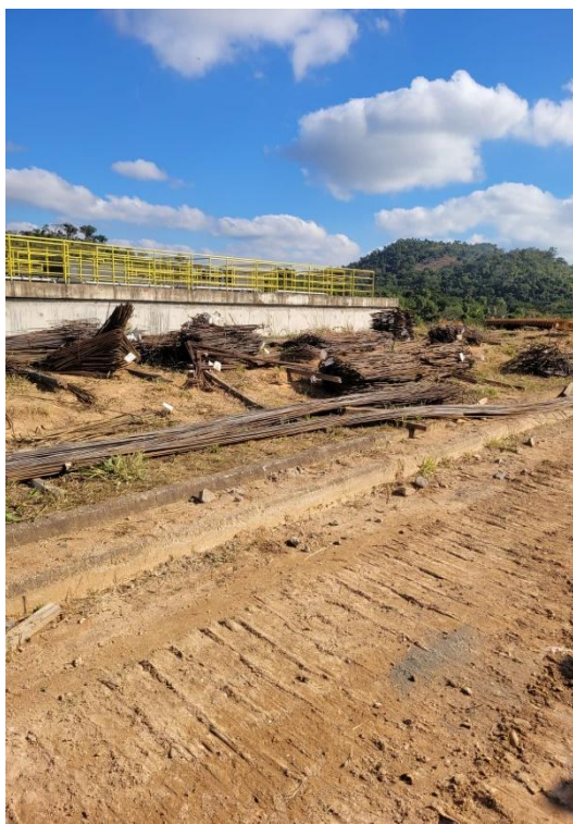
Figura TEC 5 - Vista da nova ETE
