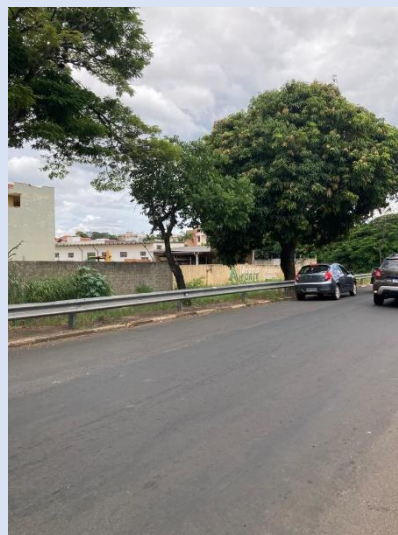
Trecho de obra já executado
