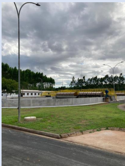
Estrutura do novo reator biológico
