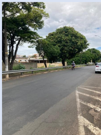
Trecho de obra já executado
