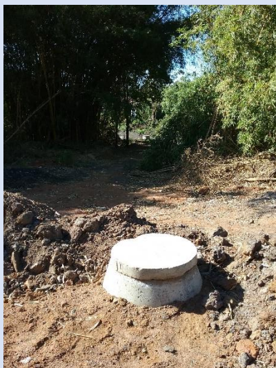
Trecho de obra já executado
