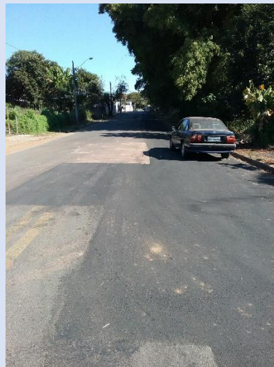
Trecho de obra já executado
