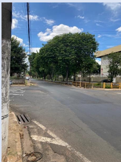
Trecho de obra já executado – Ponto próximo ao colégio Imaculada Conceição
