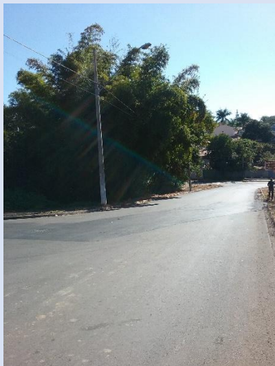
Trecho de obra já executado
