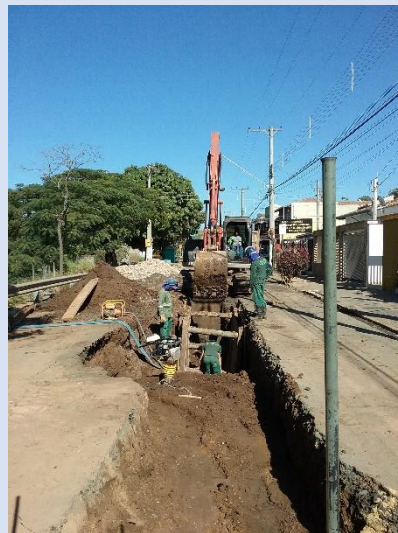
Trecho de obra em execução
