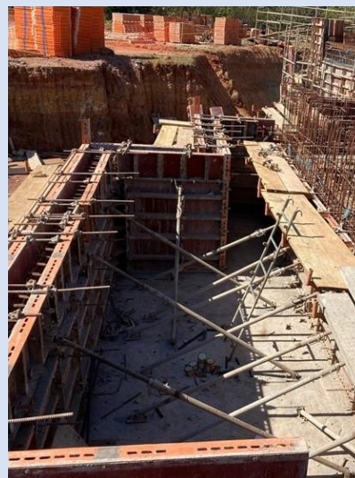
Estrutura em execução – poço bombamento de lodo
