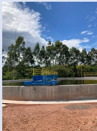
Novo decantador secundário em operação
