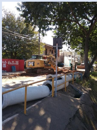
Trecho de obra em execução
