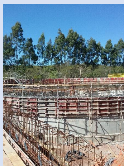
Estrutura em execução do decantador secundário
