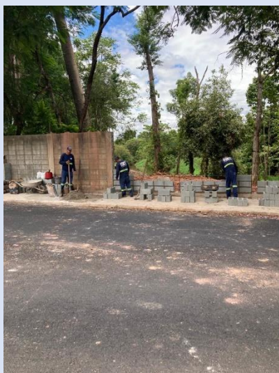
Fechamento da alvenaria do muro
