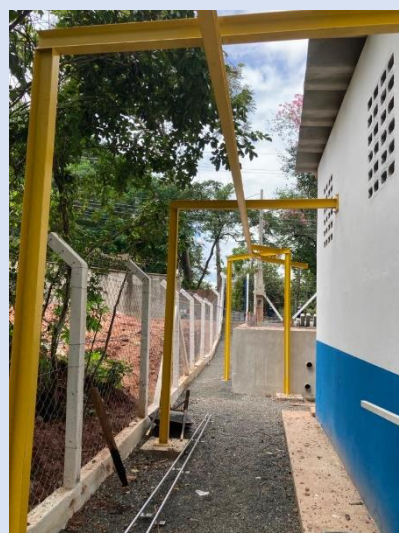
Elevatória dos Ferroviários
