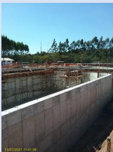
Estrutura em execução do reator biológico
