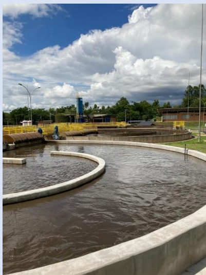
Vista geral dos reatores
