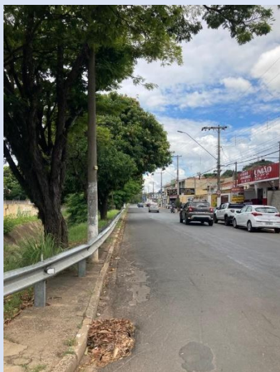
Trecho de obra já executado
