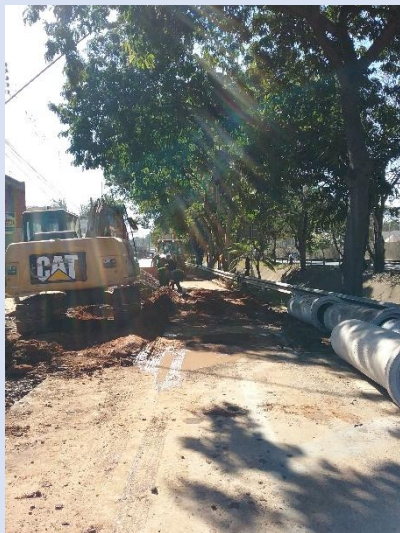
Trecho de obra em execução
