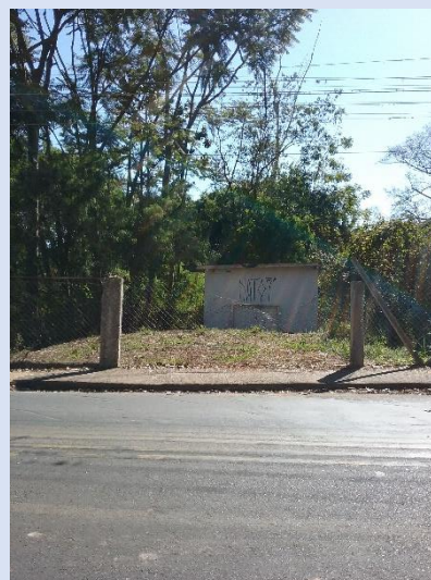
Elevatória dos Ferroviários – Inativa mas operada pelo SAAE onde o trecho a ser construído do emissário irá se conectar.
