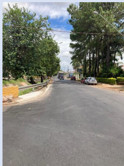
Trecho de obra já executado
