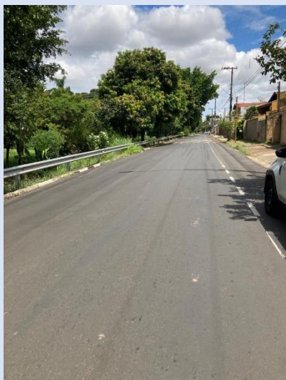
Trecho de obra já executado
