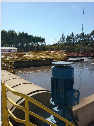
Tanque de aeração
