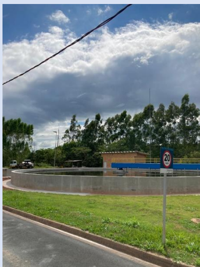
Vista geral do decantador
