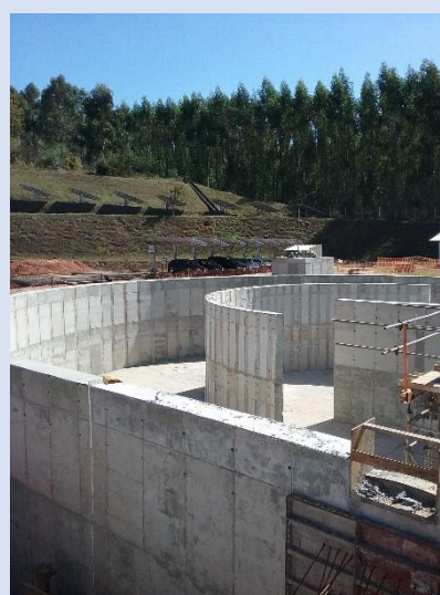
Paredes concretadas do reator biológico
