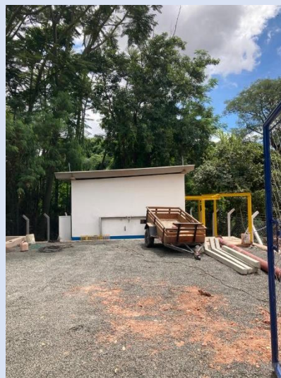
Elevatória dos Ferroviários
