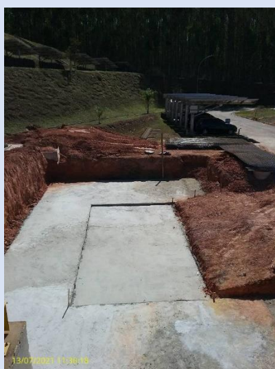
Base de concreto do tratamento preliminar
