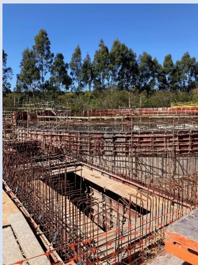
Vista geral das estruturas em execução
