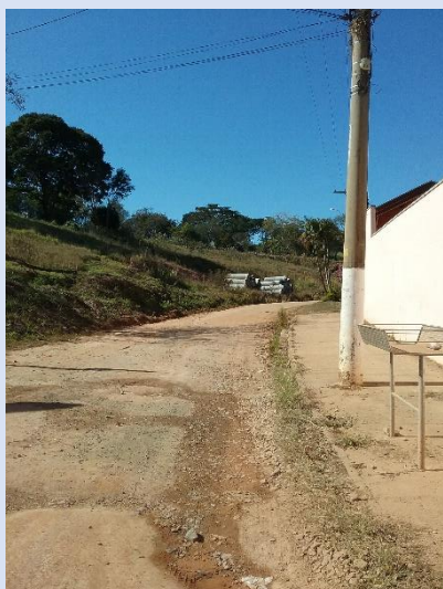
Armazenagem de material para a obra do emissário
