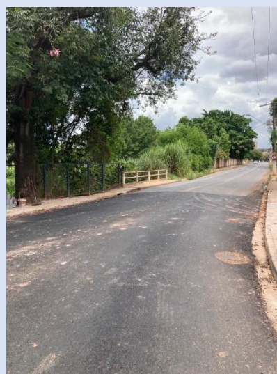
Vista da rua em frente à Elevatória dos Ferrovários
