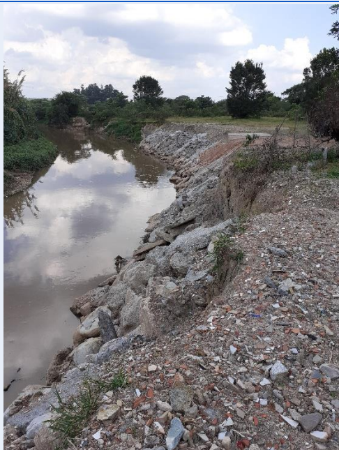
Intervenção feita pela CSJ para controle de erosão da margem esquerda do Rio Jundiaí Fonte: Imagem fornecida pela CSJ
