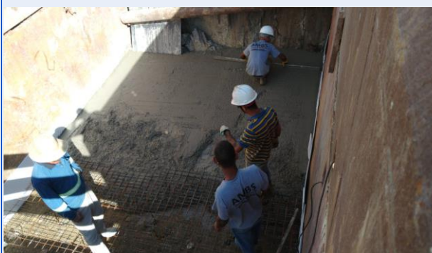
Construção da base do tanque de recalque Fonte: Fornecido pela CSJ
