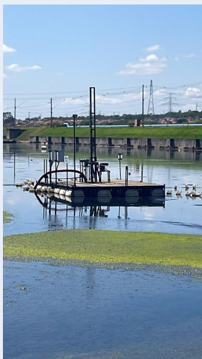
Balsas com as bombas de dragagem em visita no dia 31/10/2024
