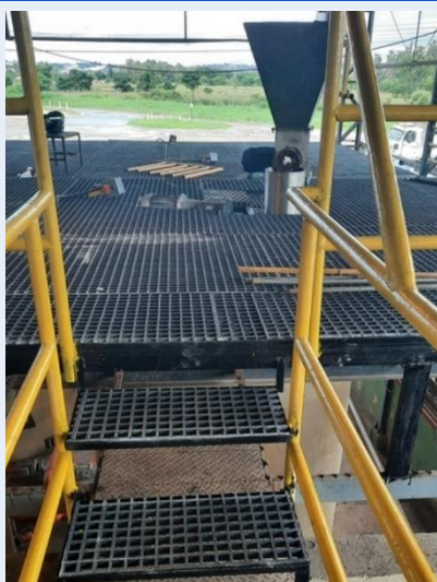
Construção da proteção do galpão de lodo para cumprimento da NR12 Fonte: Fornecido pela CSJ
