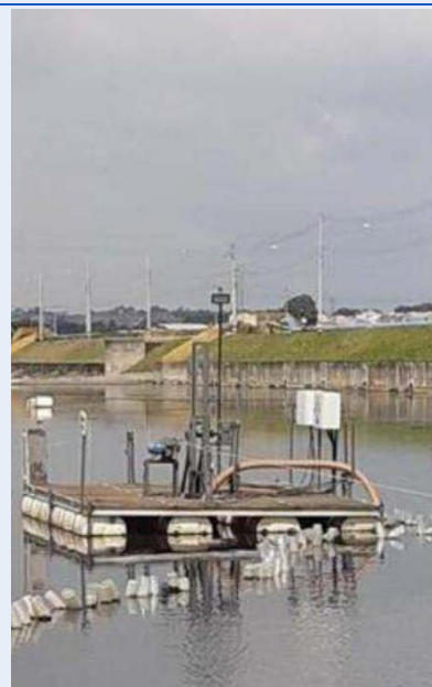
Novas balsas com bombas de dragagem mais potentes Fonte: Fornecido pela CSJ
