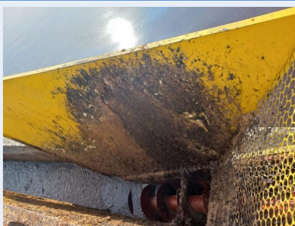
Proteção das partes móveis das roscas parafuso para cumprimento da NR12 Fonte: Fornecido pela CSJ
