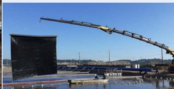
Lançamento do protótipo da cortina na lagoa de aeração 01 Fonte: Fornecido pela CSJ
