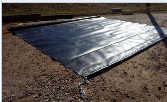
Protótipo da cortina p/ compartimentação da lagoa de aeração Fonte: Fornecido pela CSJ
