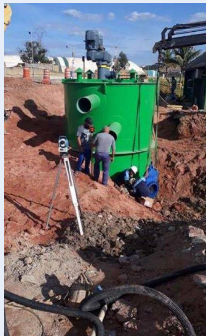
Construção da base de separação do recalque Fonte: Fornecido pela CSJ
