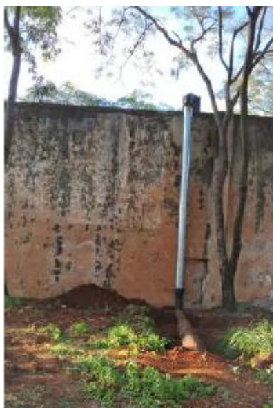
Figura TEC 14 – Interligação adutora Lagoinha (Fonte:SAERP)
