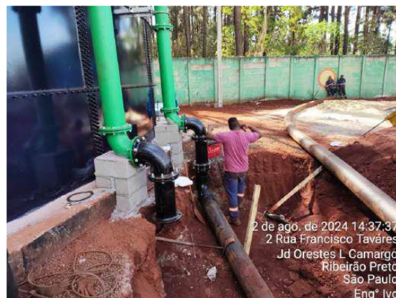
Figura TEC 16 – Interligação adutora Orestes Lopes e Rigon (Fonte:SAERP)
