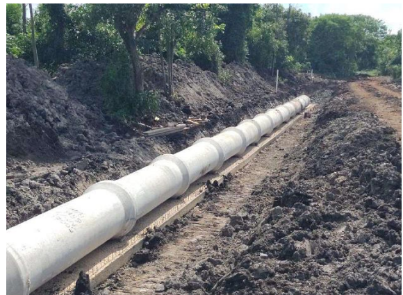
Figura TEC 24 – Implantação de coletor tronco - Pq. Ind. Tanquinho (Fonte: SAERP)
