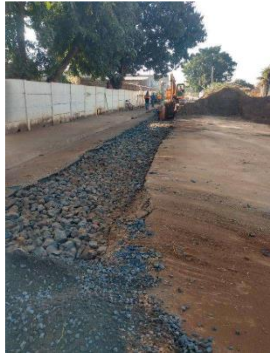
Figura TEC 24 – Implantação de coletor tronco - Pq. Ind. Tanquinho (Fonte: SAERP)
