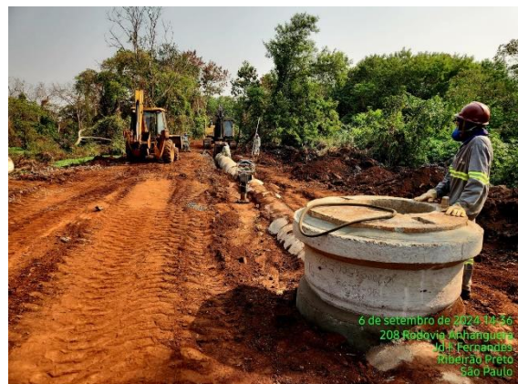
Figura TEC 25 – Substituição de Coletor Tronco no Bairro Jd. Salgado Filho
