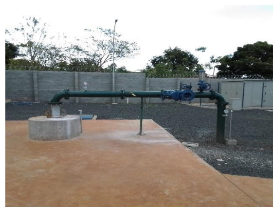
Figura TEC 6 – Poço tubular profundo Paiva em operação(novo) e obras concluídas
