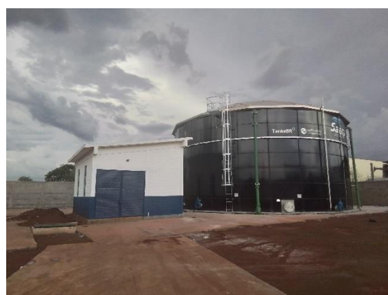
Figura TEC 9 – Reservatório (Volume 2000m3) e EEAT Tanquinho
