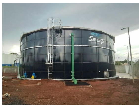
Figura TEC 11 – Reservatório Parque Ribeirão (Volume 2000m3) em operação
