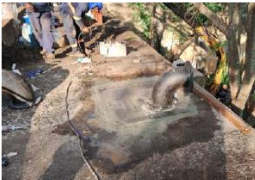
Figura TEC 14 – Interligação adutora Lagoinha (Fonte:SAERP)
