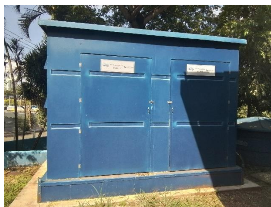
Figura TEC 21– Abrigos de PRFV para armazenamento e dosagem de cloro e flúor
