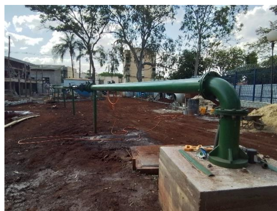
Figura TEC 4 – Poço tubular profundo Ciane em obras (novo)
