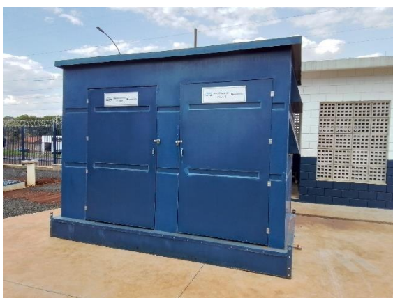
Figura TEC 21– Abrigos de PRFV para armazenamento e dosagem de cloro e flúor
