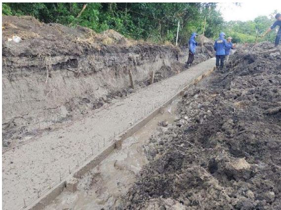
Figura TEC 24 – Implantação de coletor tronco - Pq. Ind. Tanquinho (Fonte: SAERP)
