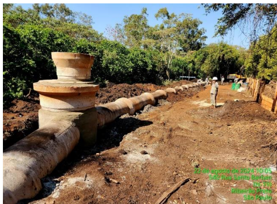
Figura TEC 25 – Substituição de Coletor Tronco no Bairro Jd. Salgado Filho
