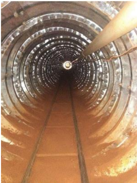
Figura TEC 24 – Implantação de coletor tronco - Pq. Ind. Tanquinho (Fonte: SAERP)
