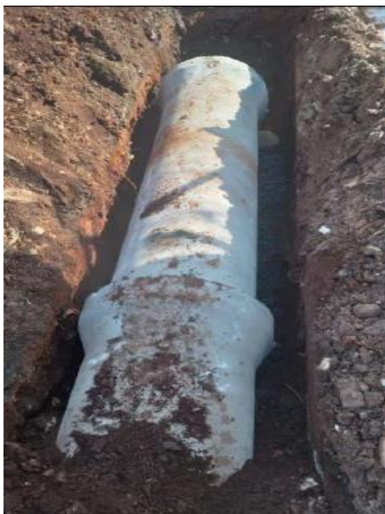
Figura TEC 23 – Substituição de Coletor Tronco na Av. Aniceto dos Santos Lote (Fonte: SAERP)
