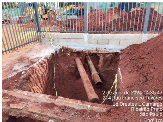
Figura TEC 16 – Interligação adutora Orestes Lopes e Rigon (Fonte:SAERP)
