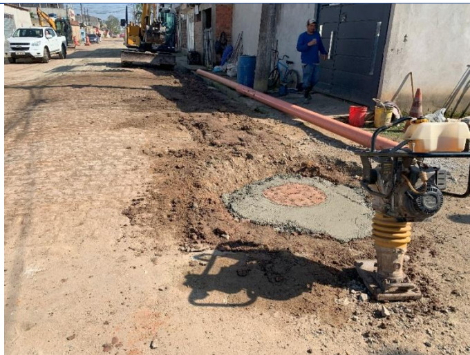
Figura 9 - Execução de PV no bairro.
