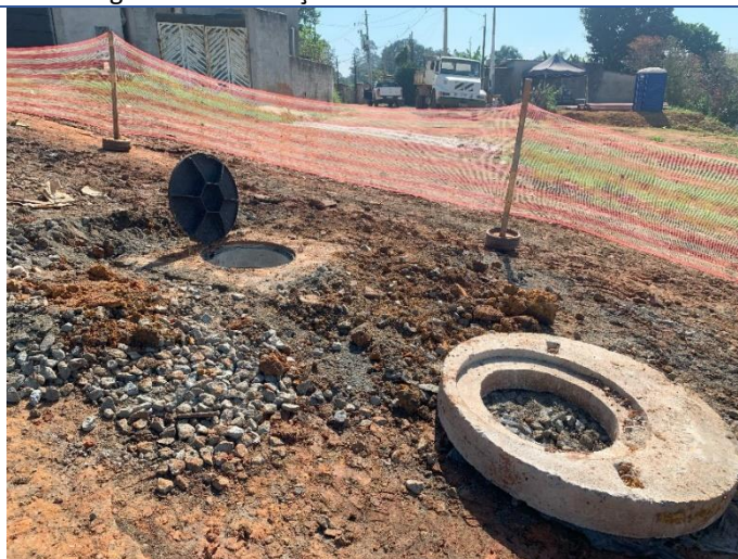
Figura 7 - Instalação de PV entre as ruas 2 e 3.
