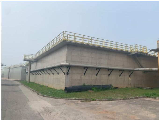
Figura 17 - Tubulação do soprador do novo tanque de aerção - concluído.
