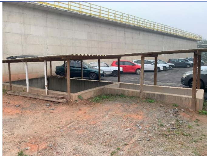
Figura 13 - Preliminar para caminhão limpa fossa - falta equipamentos internos.
