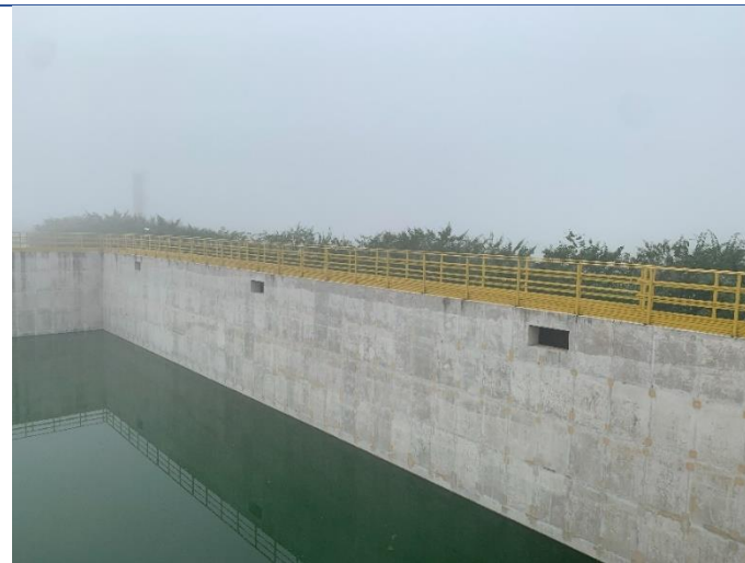
Figura 14 - Novo tanque de aeração - estanqueidade testada - falta interligação hidráulica.
