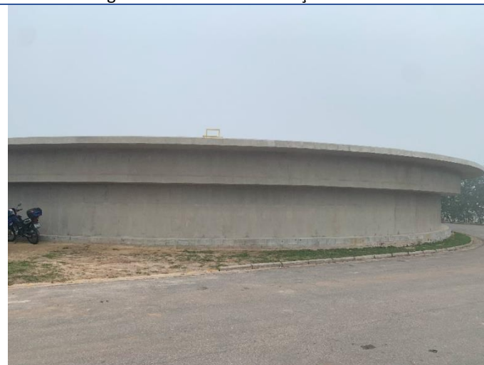
Figura 12 - Novo decantador secundário - falta interligação hidráulica.
