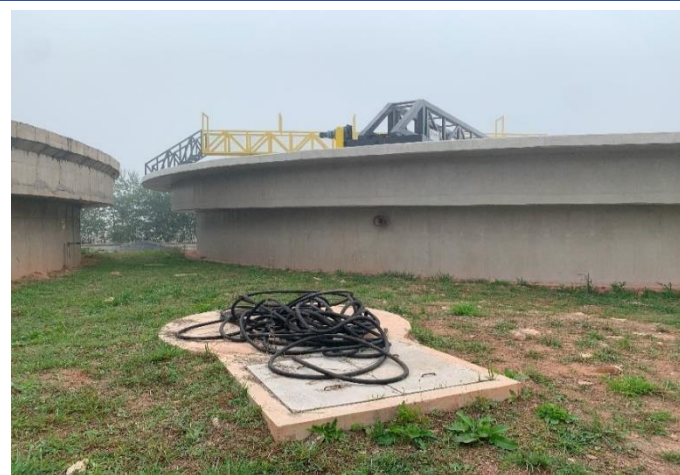
Figura 20 - Sistema de recirculação de lodo - falta interligação hidráulica.
