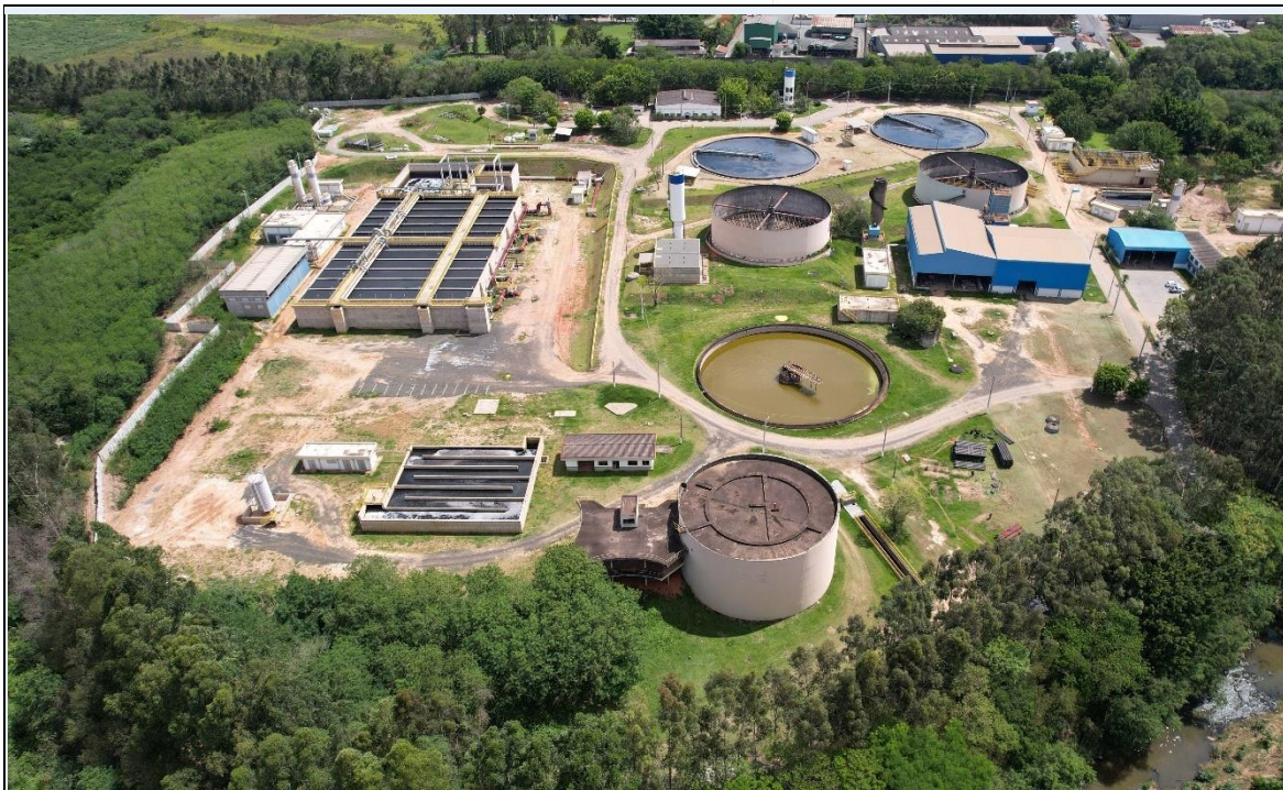
Figura 18: Imagem de drone ETE Tatu (nov22)
