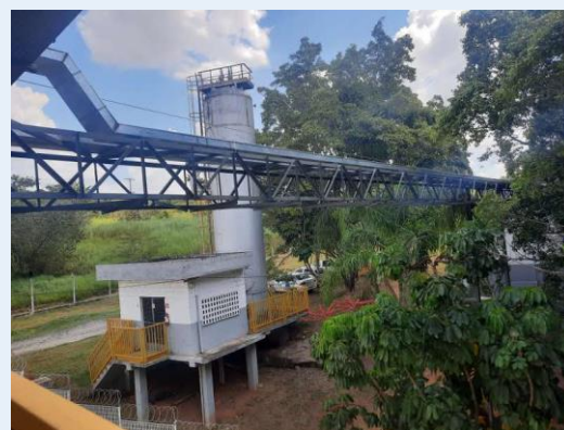
Figura 6: Melhorias realizadas na EEAB São Lucas
