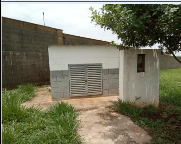
Figura 12: Vista externa do booster Itapema (nov23)
