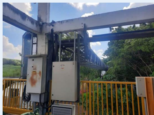
Figura 5: Melhorias elétricas realizadas na EEAB São Lucas
