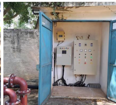
Fotos 3 e 4 – Substituição de tubulações e acessórios hidráulicos e painel elétrico da EEE Vila Rica.
