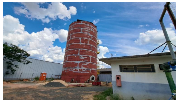
Foto 2 – Novo reservatório do CR Vila Rica.
