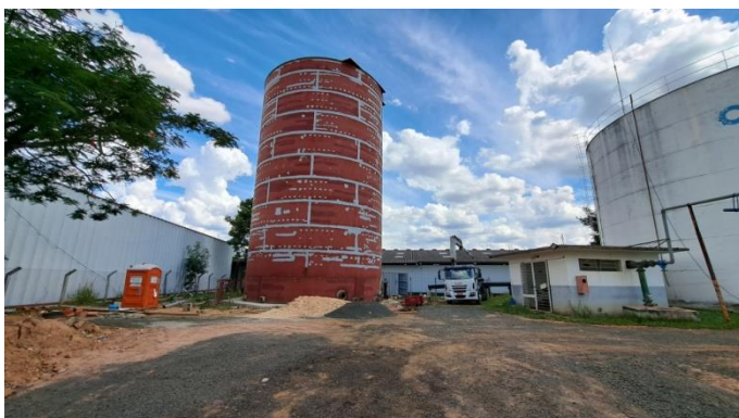
Foto 1 – Novo reservatório do CR Vila Rica.
