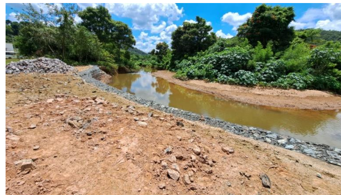
Foto 2 – Recuperação e estabilização da margem do Ribeirão Guaçu.
