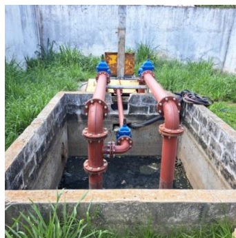
Fotos 5 e 6 – Substituição de tubulações e acessórios hidráulicos e do painel elétrico da EEE Paraíso.
