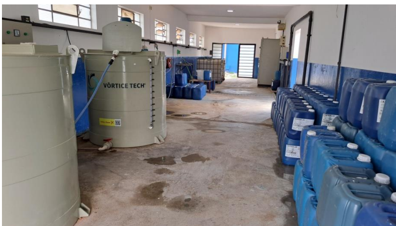
Foto 3 – Novo depósito de produtos químicos da ETA Itaim.
