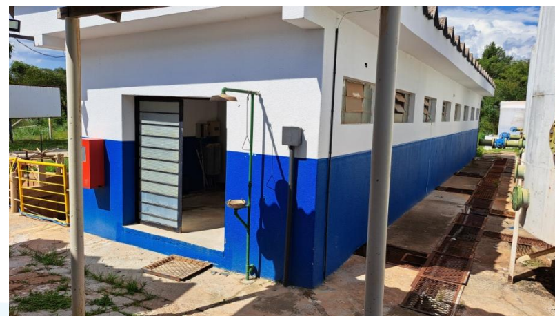
Foto 4 – Reforma estrutural de prédio da ETA Itaim.
