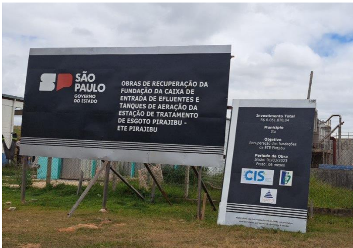
Foto 1 – Placa das obras de reforma da fundação da ETE Pirajibu.
