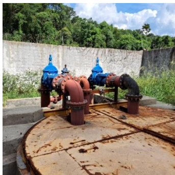
Fotos 1 e 2 – Substituição de tubulações e acessórios hidráulicos e painel elétrico da EEE Cidade Nova.
