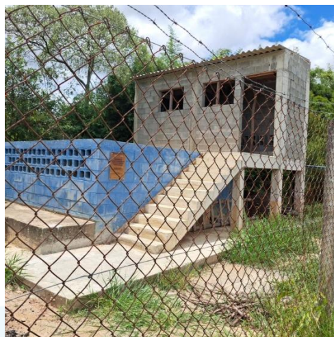
Foto 3 – Vista externa das obras da Elevatória Tapera Grande.
