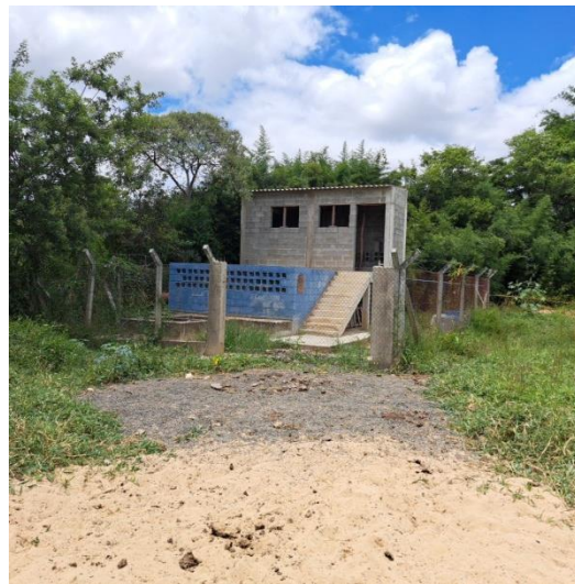
Foto 2 – Vista externa das obras da Elevatória Tapera Grande.
