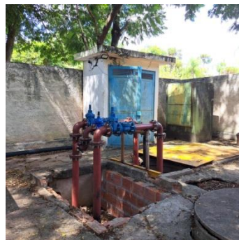
Fotos 3 e 4 – Substituição de tubulações e acessórios hidráulicos e painel elétrico da EEE Vila Rica.
