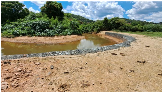
Foto 1 – Recuperação e estabilização da margem do Ribeirão Guaçu.
