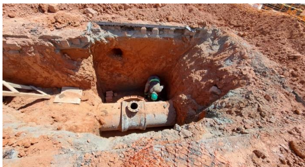
Foto 3 – Instalação da adutora de água bruta da nova Captação Utu-Guaçu.
