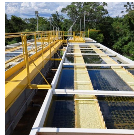
Foto 2 – Vista dos decantadores da ETA Itaim.
