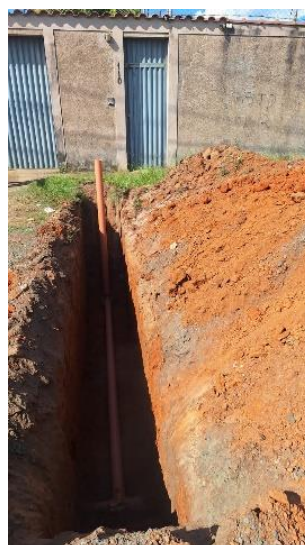
Figura TEC 3: Construção das redes de esgoto e ramais de esgoto na Avenida Eduardo Karklis Fonte: CODEN,2024
