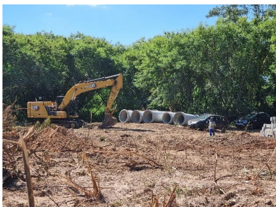
Figura TEC 4: Reparo emergencial do coletor de esgoto do Ribeirão Quilombo Fonte: CODEN,2024
