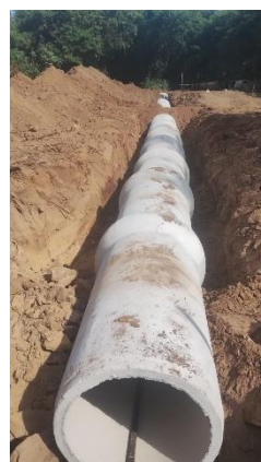
Figura TEC 4: Reparo emergencial do coletor de esgoto do Ribeirão Quilombo Fonte: CODEN,2024
