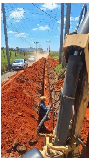
Figura TEC 3: Construção das redes de esgoto e ramais de esgoto na Avenida Eduardo Karklis Fonte: CODEN,2024
