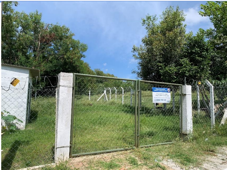
Figura 4 - Vista externa do poço Castellani Ecoporto.
