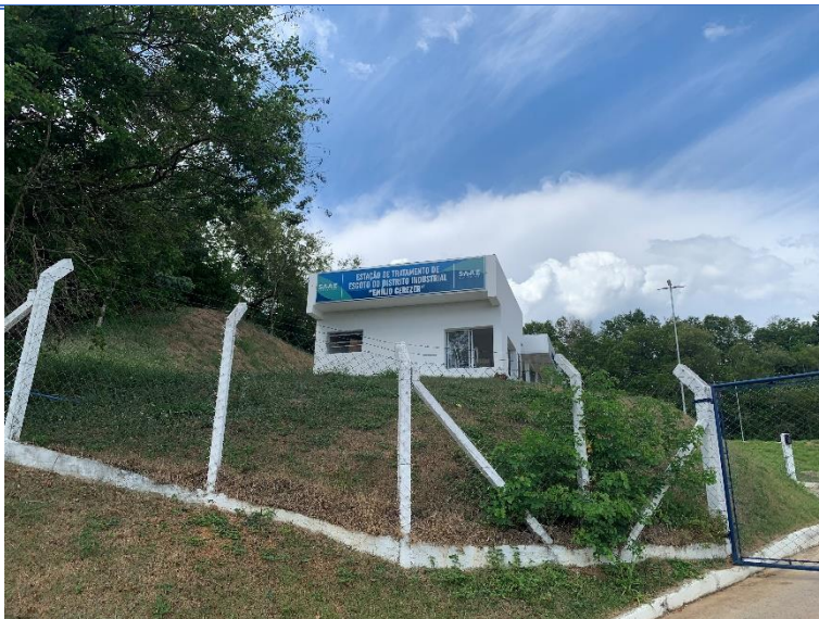
Figura 40 - ETE DIC 1. Em operação.
