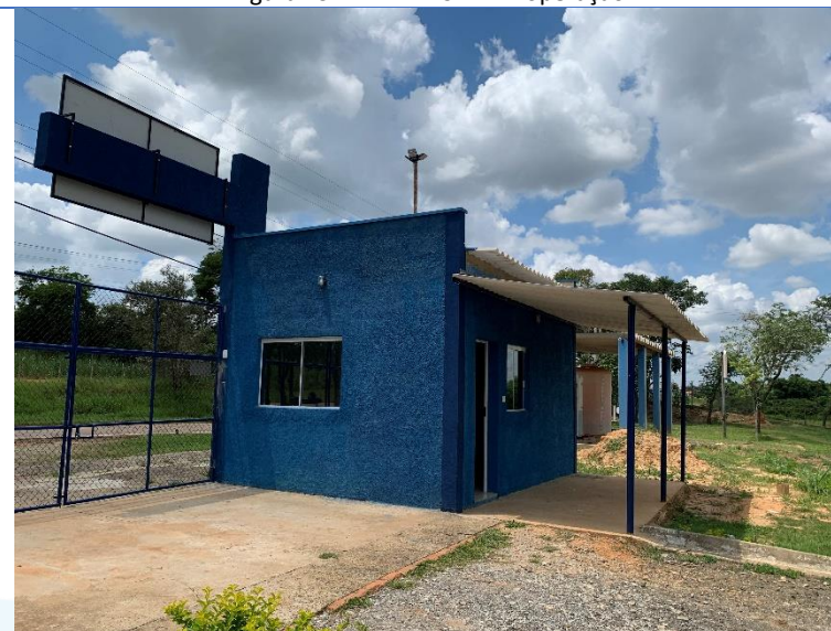
Figura 51 - Nova guarita da ETA II.
