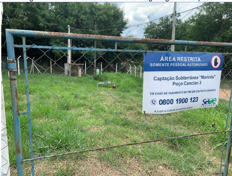
Figura 34 - Vista externa do poço Marinês.
