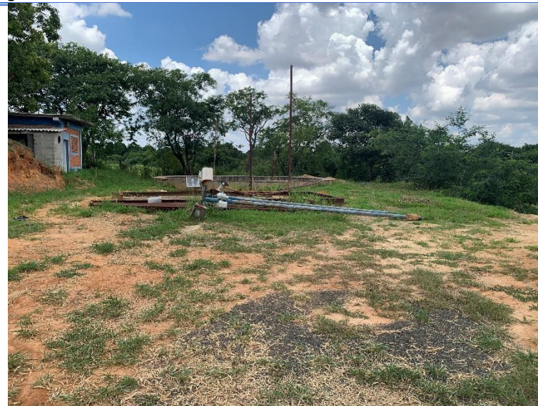
Figura 37 - Postes substituídos da ETA II.
