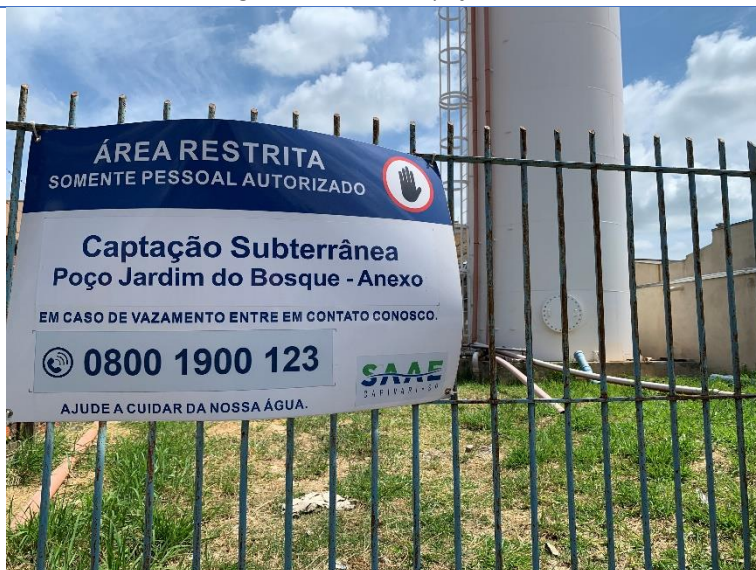
Figura 14 - Acesso ao poço Jardim do Bosque Anexo.
