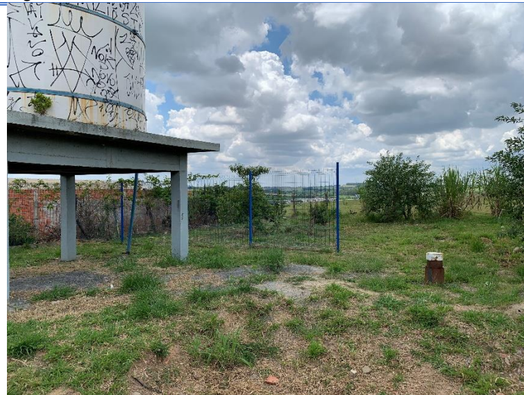
Figura 9 - Poço Santa Rita do Trevo Anexo. Apenas perfurado.
