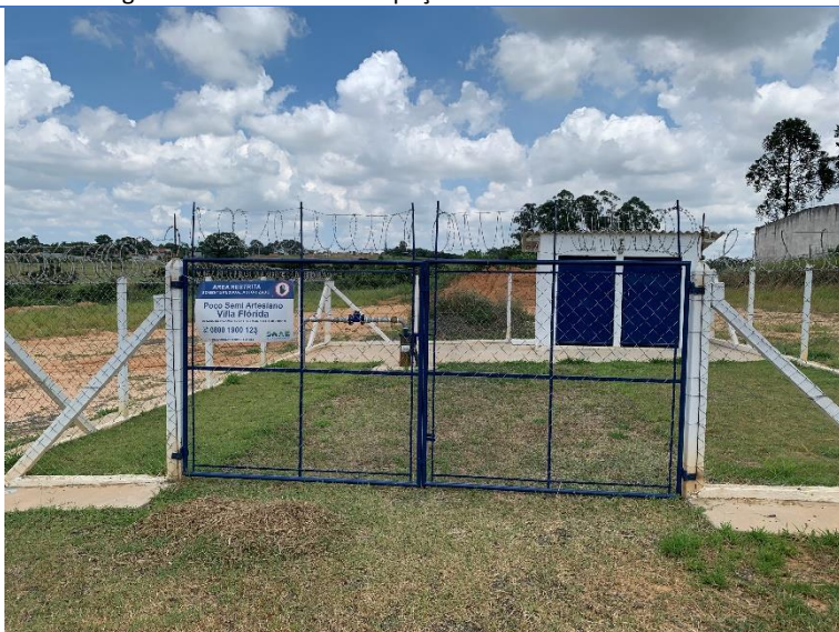
Figura 10 - Vista externa do poço Flórida.
