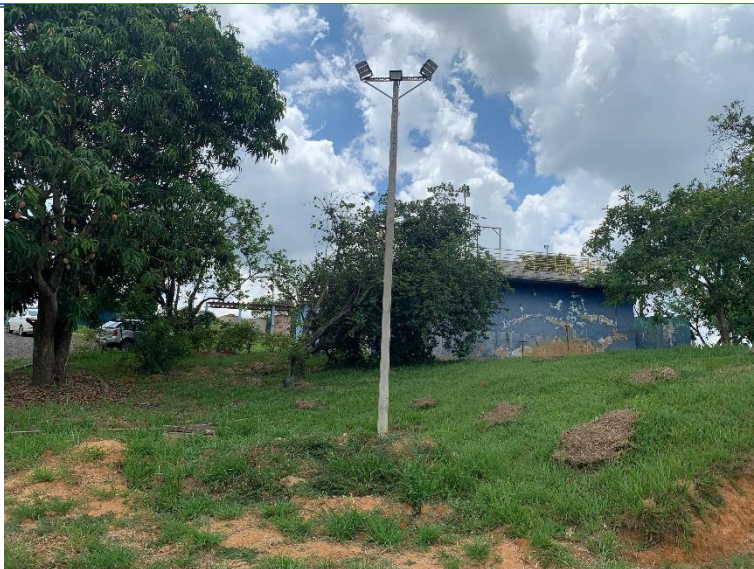
Figura 36 - Novo poste e iluminação da ETA II.
