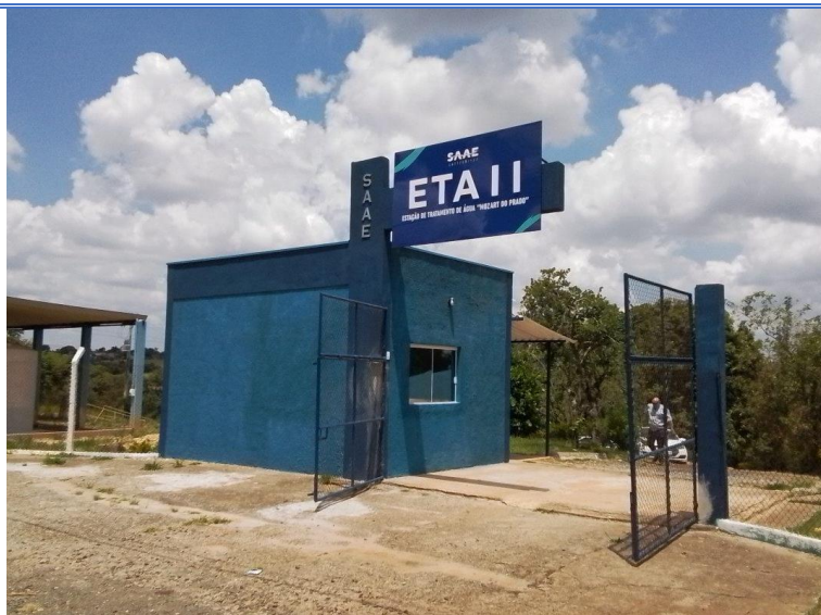
Figura 12 - Acesso ao poço ETA II.
