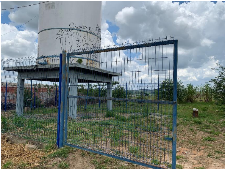
Figura 8 - Vista externa do poço Santa Rita do Trevo Anexo.
