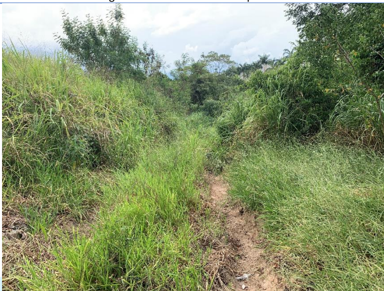
Figura 46 - Acesso para a EEE 3 DIC 1. Não operante.
