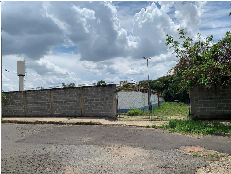
Figura 32 - Vista externa da ETE Porto Alegre e guarda-corpos.
