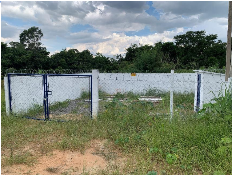
Figura 48 - EEE 4 DIC 1. Em operação.
