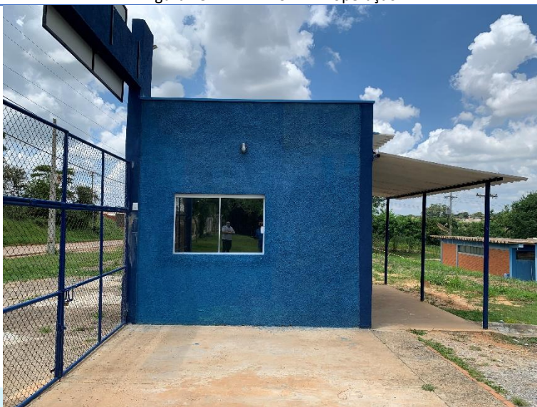
Figura 50 - Nova guarita da ETA II.
