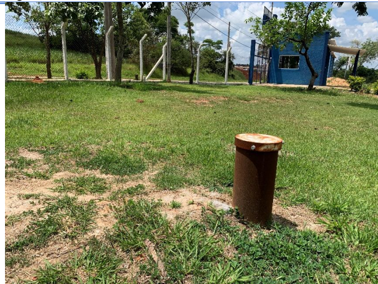
Figura 13 - Poço ETA II. Apenas perfurado.
