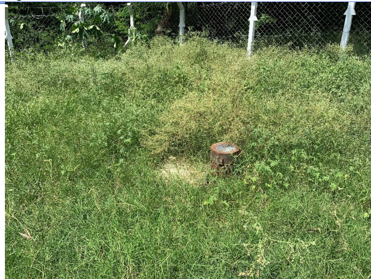
Figura 5 - Poço Castellani Ecoporto. Falta instalar bomba e painel elétrico.
