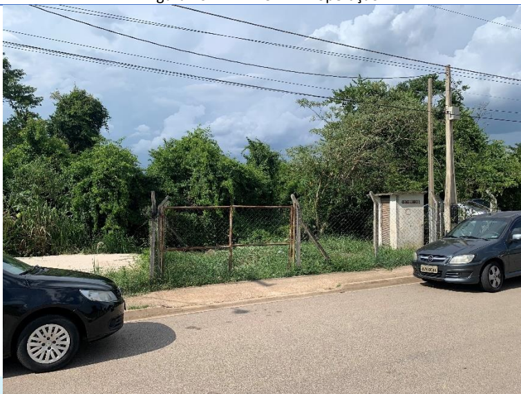
Figura 42 - EEE 1 DIC 1. Não operante.
