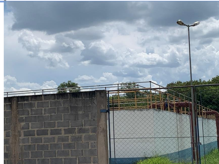
Figura 33 - Aumento dos guarda-corpos da ETE Porto Alegre.
