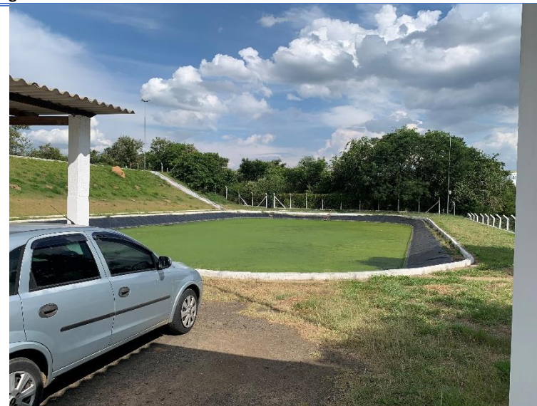
Figura 41 - ETE DIC 1. Em operação.
