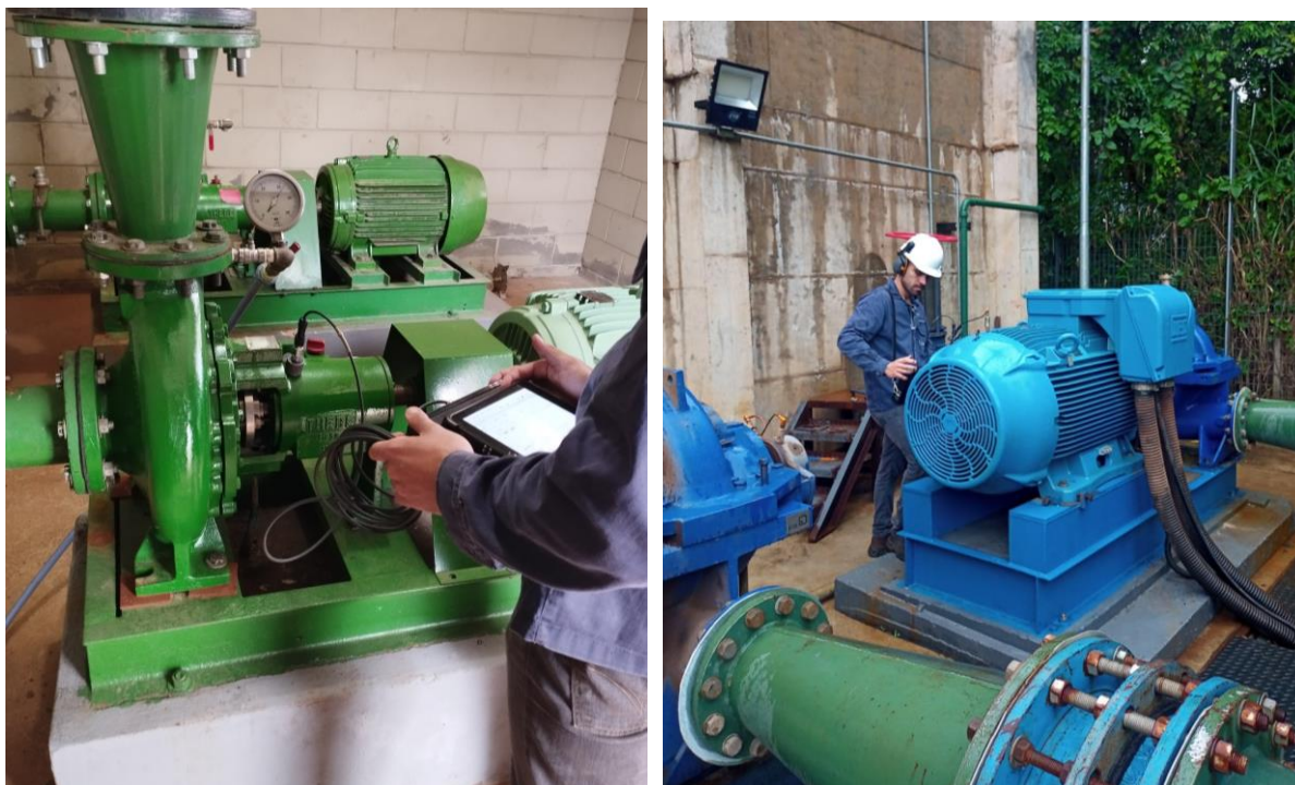
Figura 1. Análise de vibração em conjuntos motobombas.
