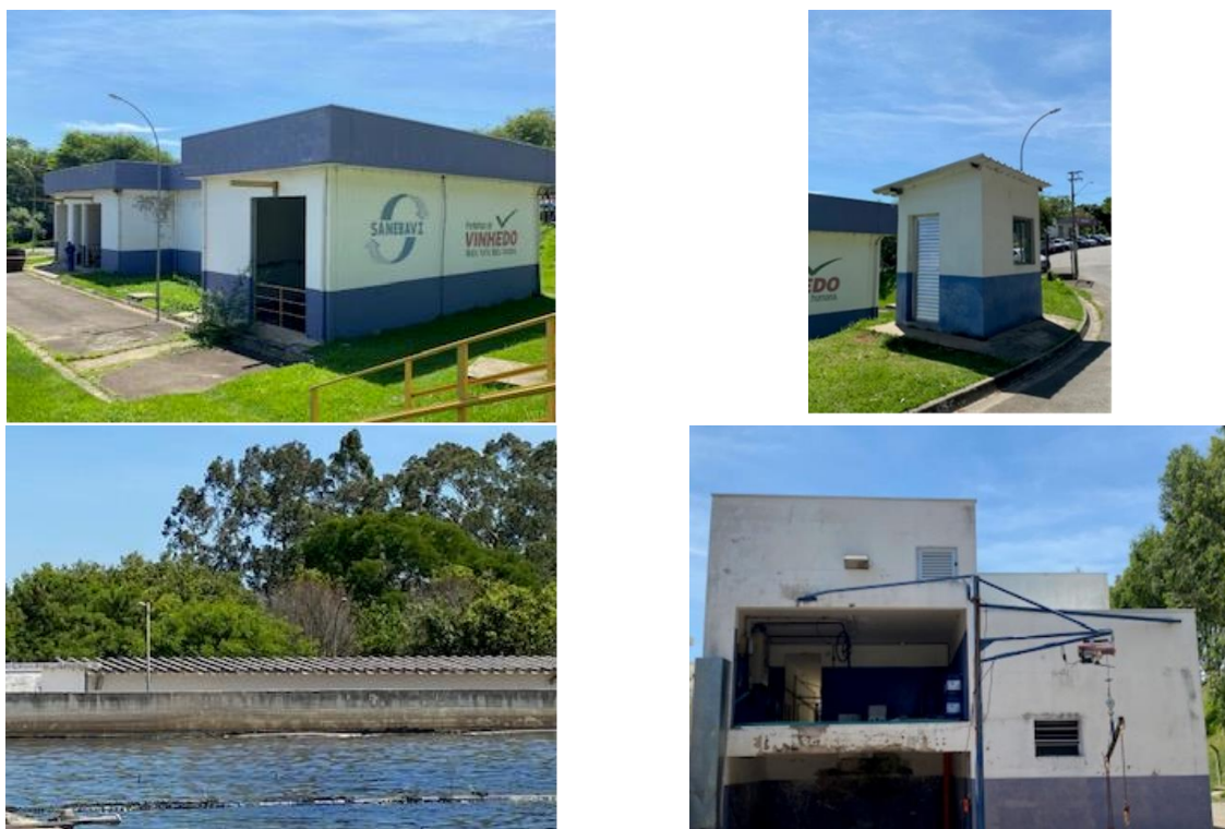
Figura TEC 5 – Reforma dos telhados da elevatória, guarita, administração e casa de química da ETE Capivari
