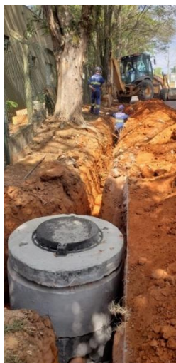
Figura TEC 10 – Extensão de rede de esgoto na Rua Moacir Delaqua (Fonte: SANEBAVI)
