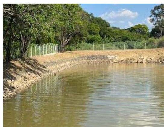
Figura TEC 9– Contenção de Talude no Recalque do Pinheirinho
