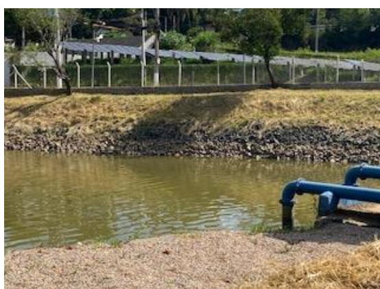
Figura TEC 9– Contenção de Talude no Recalque do Pinheirinho
