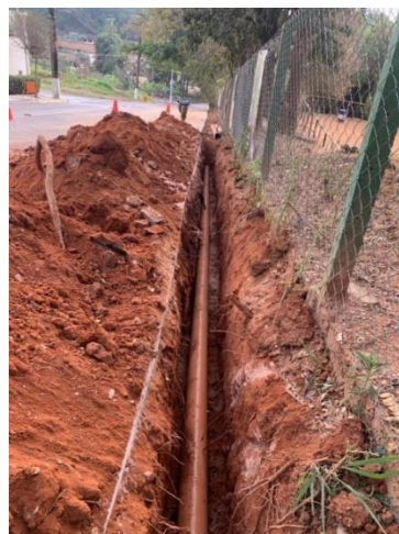
Figura TEC 10 – Extensão de rede de esgoto na Rua Moacir Delaqua (Fonte: SANEBAVI)
