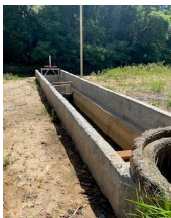
Figura TEC 8 – Tomada de água e enrocamento da Captação do Rio Capivari
