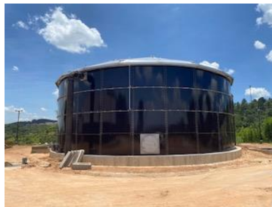
Figura TEC 1 – Novos reservatórios do Observatório e do Mirante (1.000 m 3 cada)
