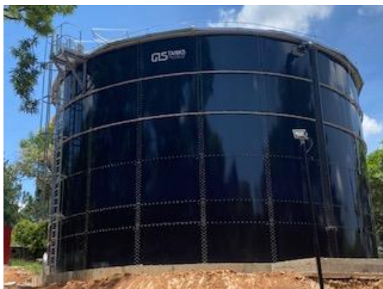
Figura TEC 1 – Novos reservatórios do Observatório e do Mirante (1.000 m 3 cada)
