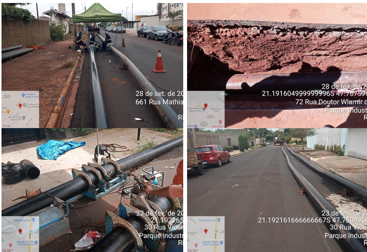
Figura TEC 1 – Execução de adutora e redes para implantação de setores de abastecimento de água em Ribeirão Preto (Fonte: SAERP)
