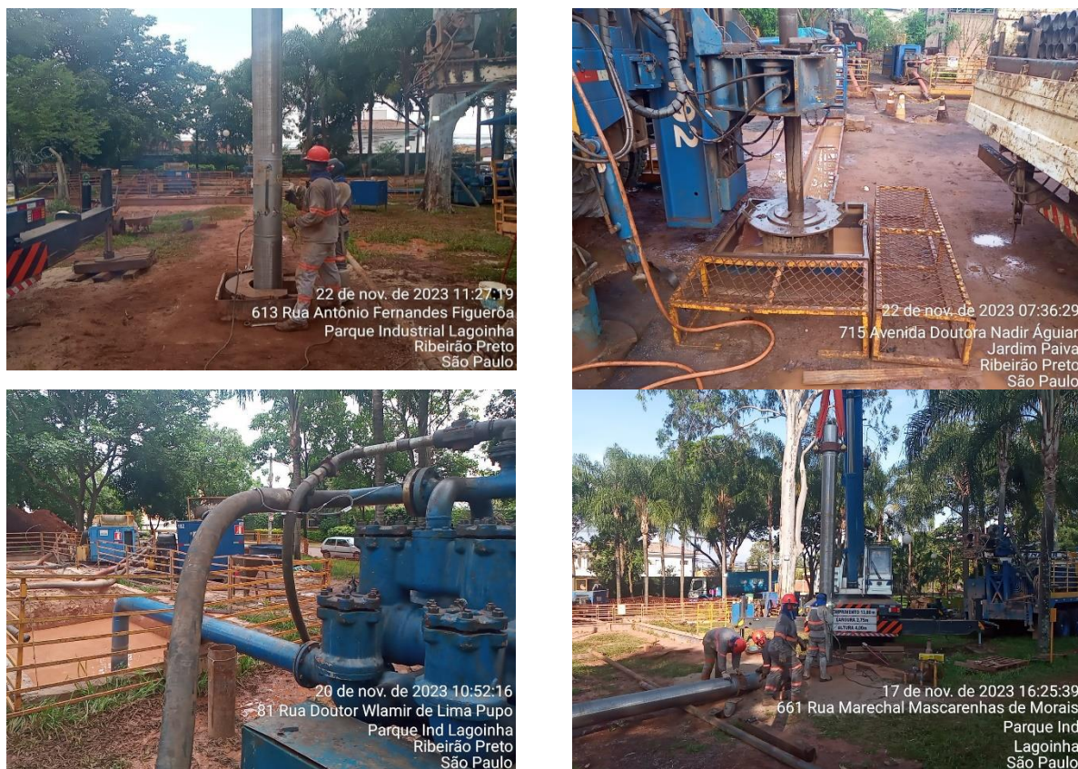
Figura TEC 2 – Execução de poços tubulares profundos em Ribeirão Preto (Fonte: SAERP)
