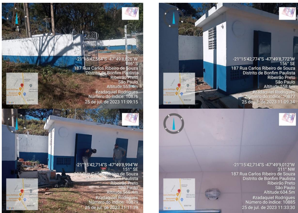
Figura TEC 17 – Reformas estruturais operacionais (Bonfim Paulista): Fonte: SAERP
