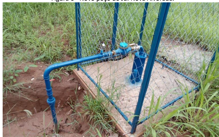
Figura 8 - Novo poço Samambaia III.
