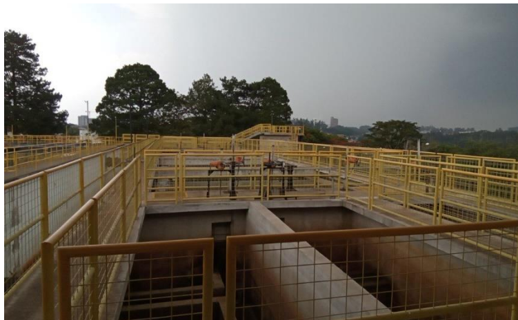
Figura 9 - Vista geral da ETA 3.
