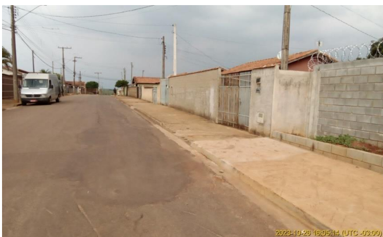
Figura 3 - Diferença no asfalto demonstrando a instalação da tubulação da adutora.
