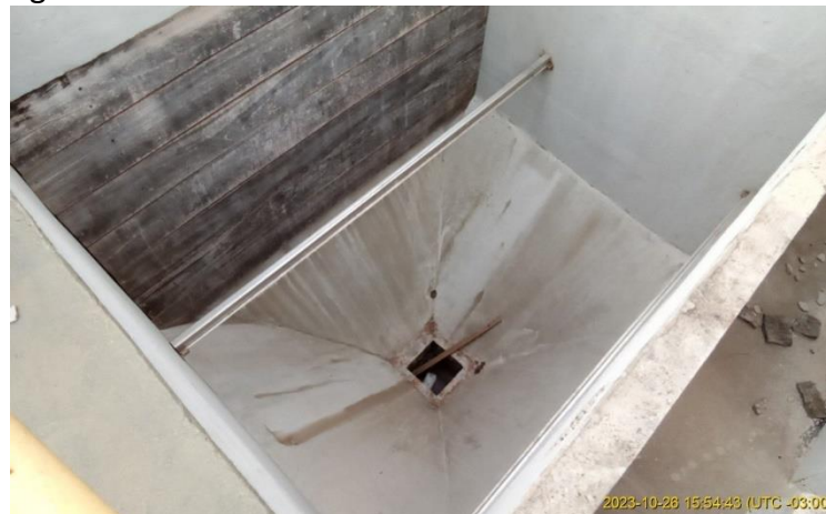
Figura 20 - Vista do fundo do decantador.
