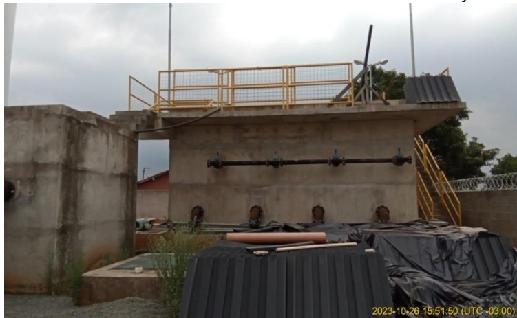
Figura 19 - Vista da ETA e dos perfis laminares dos decantadores.
