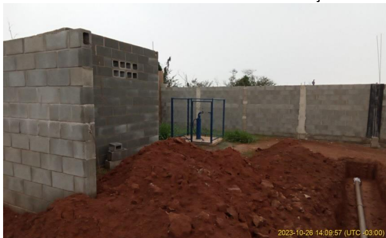
Figura 5 - Local de instalação do poço Jd. Nova Alvorada em obras.
