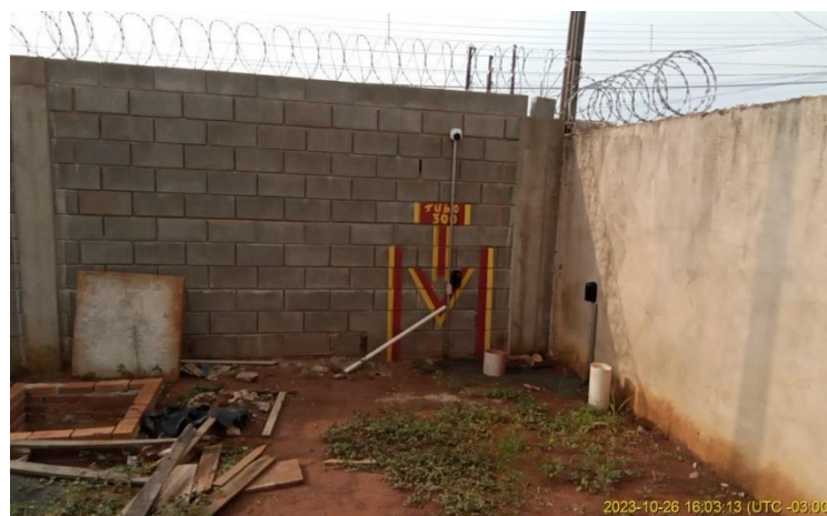
Figura 4 - Local de chegada da adutora marcado na parede da nova ETA Martinho Prado.
