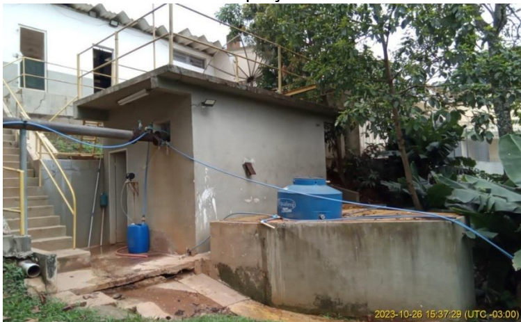
Figura 1 - Local da EEAB atual que será substituída.
