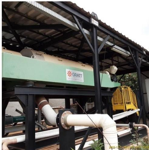
**Figura TEC 3 – Centrifuga de lodo da ETA.**
