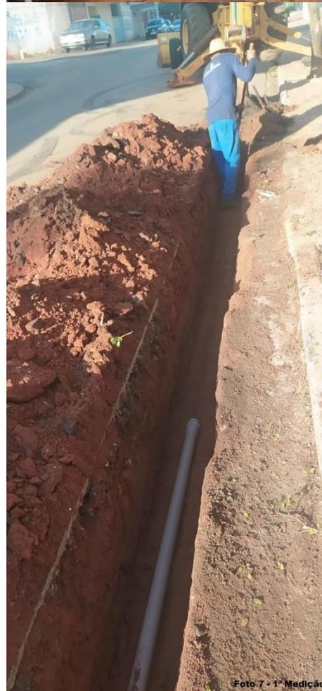
**Figura TEC 1 – Substituição de rede no Jardim Amália (Fonte: SAECIL)**
