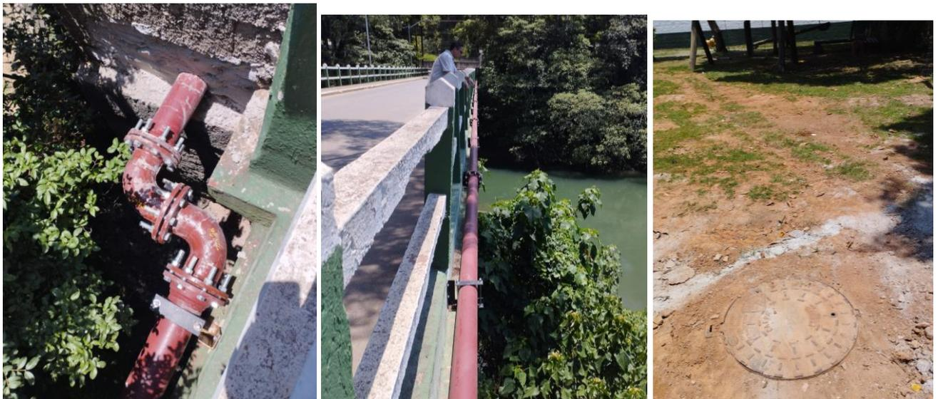
**Figura 11.** Linha de recalque da futura estação elevatória de esgoto (EEE) Vila Modesto, para interligação com interceptor que encaminha o efluente à EPAR; PV executado próximo ao local onde será executada a EEE. (dir.).
