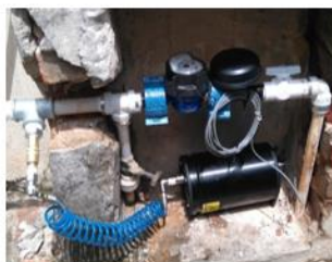
Ponto crítico Datalogger de pressão instalado em cavalete
