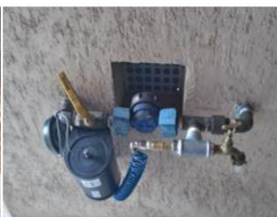
Ponto crítico Datalogger de pressão instalado em cavalete
