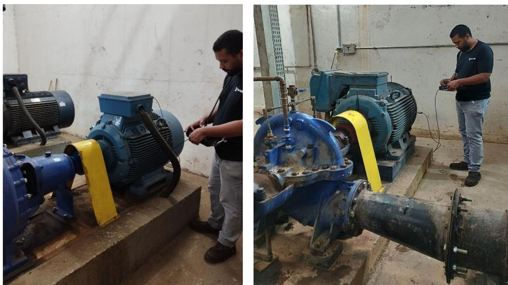
**Figura 2.** Análise de vibração de conjuntos motobomba.
