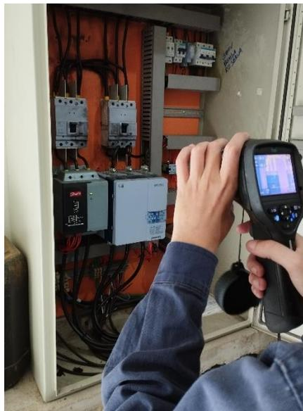
**Figura 1.** Inspeção termográfica em painel elétrico.
