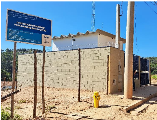
Foto 1 – Vista externa da EEAT Mato Dentro.
