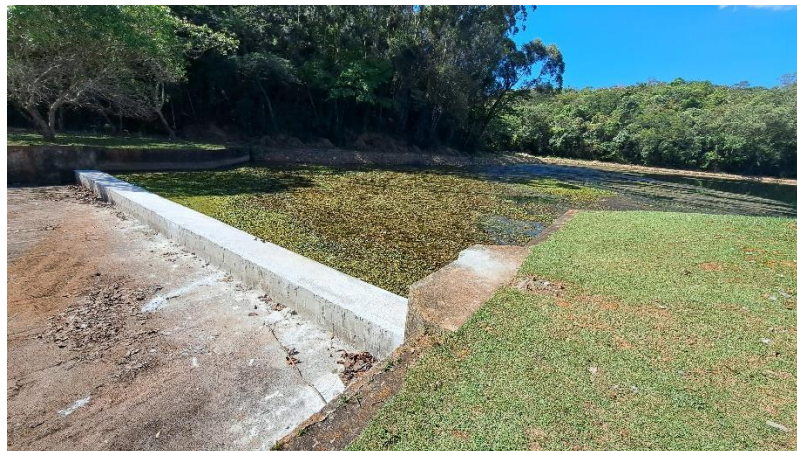
Foto 1 – Readequação de vertedouro da Captação Superficial do Rio Jundiá Mirim.
