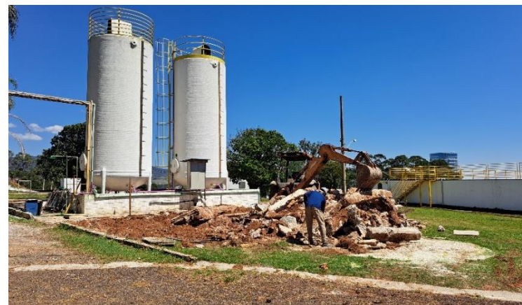
Foto 2 – Demolição e limpeza de área para construção de nova bacia de contenção de tanques de produtos químicos na ETA Anhangabaú.
