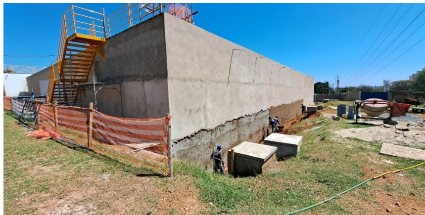
Foto 1 – Reservatório R60 da ETA Anhangabaú em obras.
