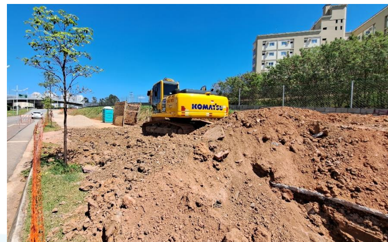
Foto 2 – Abertura de vala para execução da adutora.
