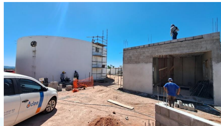
Foto 2 – Reservatório apoiado (1.000m 3 ) e estação elevatória ao lado em obras.
