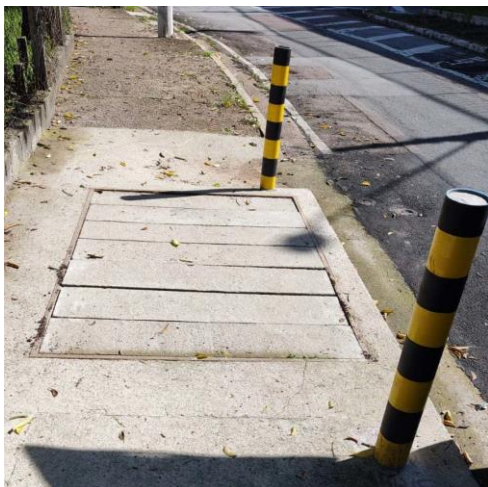
Foto 1 – Local de implantação de Válvula Redutora de Pressão e Macromedidor em passeio da via - Zona Leste de Jundiaí (Fonte: DAE, 2023).
