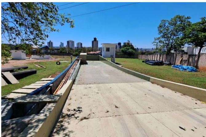
Foto 1 – Readequação do local de descarregamento de produtos químicos da ETA Anhangabaú.
