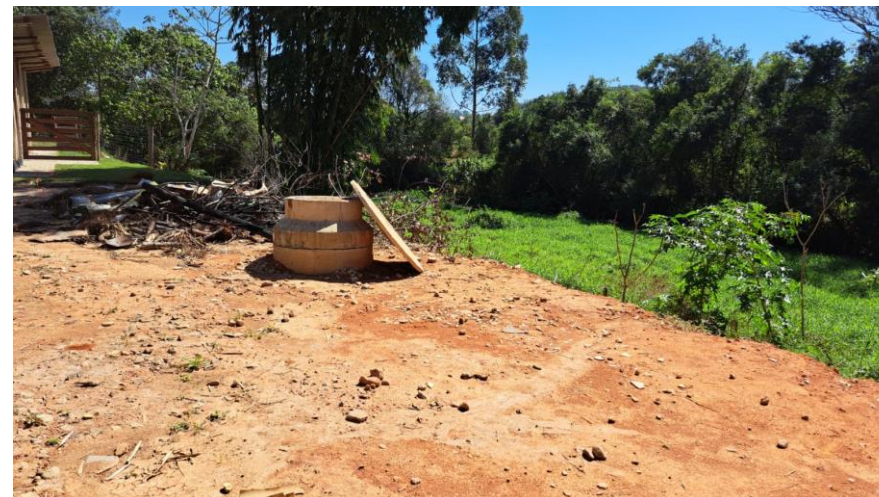
Foto 2 – Poço de visita (PV) construído durante a ampliação do sistema de esgotamento sanitário no bairro Castanho.
