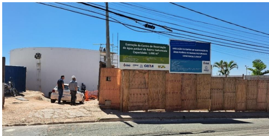
Foto 1 – Construção do Centro de Reservação no bairro Ivoturucaia.
