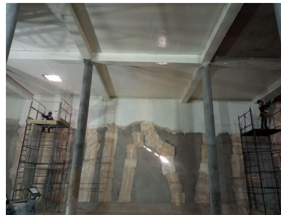
Foto 2 – Parte interna do Reservatório R60 em obras (Fonte: DAE, 2023).
