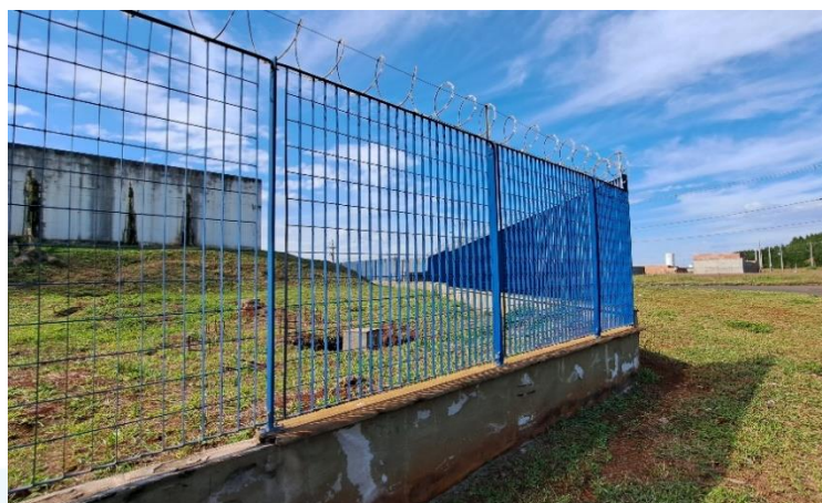
Foto 3 – Reservatório Jardim Campo Belo (ao fundo e à direita) e Reservatório Elevado José Ometto (à esquerda, dentro da área cercada), onde seria construído o Reservatório Jd Myrian.
