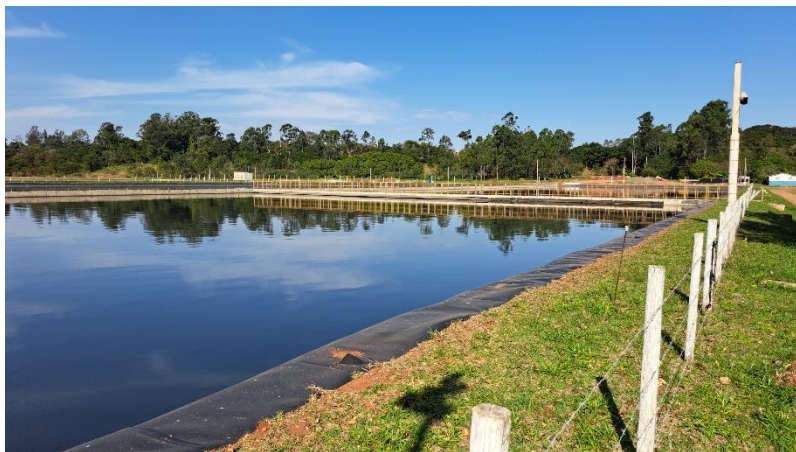
Foto 1 – Lagoa 1 da ETE Araras – em operação atualmente, mas ainda sem os equipamentos a serem adotados na concepção final da Festi Engenharia.
