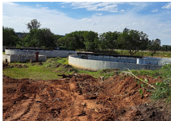
Foto 2 – Dois decantadores construídos e com parte dos equipamentos instalados (não estão em operação).
