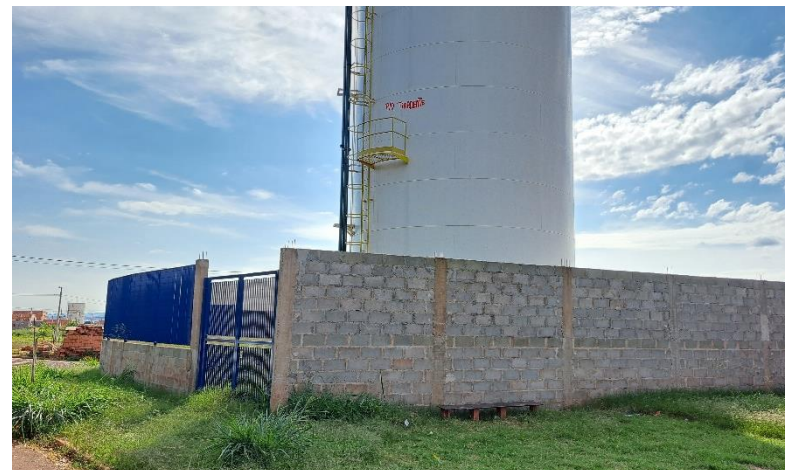
Foto 2 – Reservatório Jardim Campo Belo (à direita) e Reservatório Elevado José Ometto (ao fundo e à esquerda), onde seria construído o Reservatório Jd Myrian.
