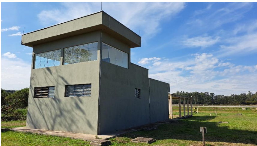
Foto 5 – Prédio onde futuramente serão os laboratórios da ETE Araras.
