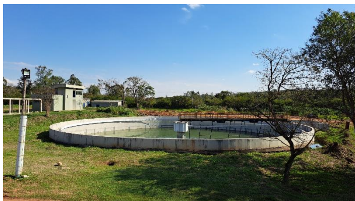
Foto 3 – Dois decantadores construídos e com parte dos equipamentos instalados (não estão em operação).
