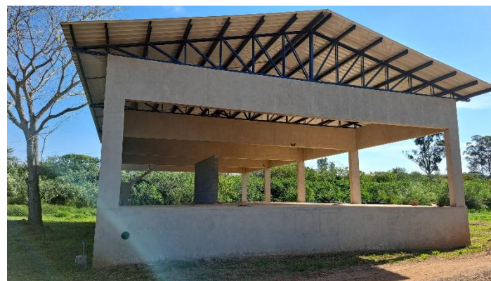
Foto 4 – Galpão onde serão instalados equipamentos para tratamento e adensamento do lodo gerado na ETE Araras
