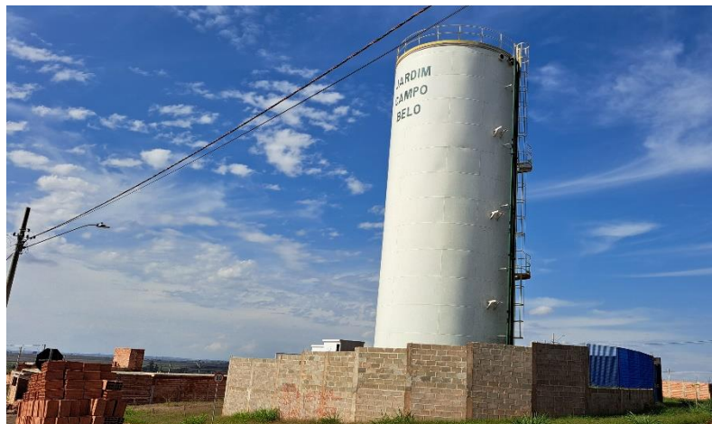
Foto 1 – Reservatório Jardim Campo Belo – substituto do Reservatório Jardim Myrian.
