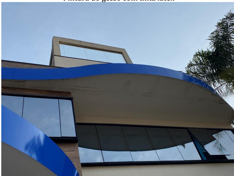
Remoção e aplicação de PU nas calhas superiores Pintura do gesso com tinta látex
