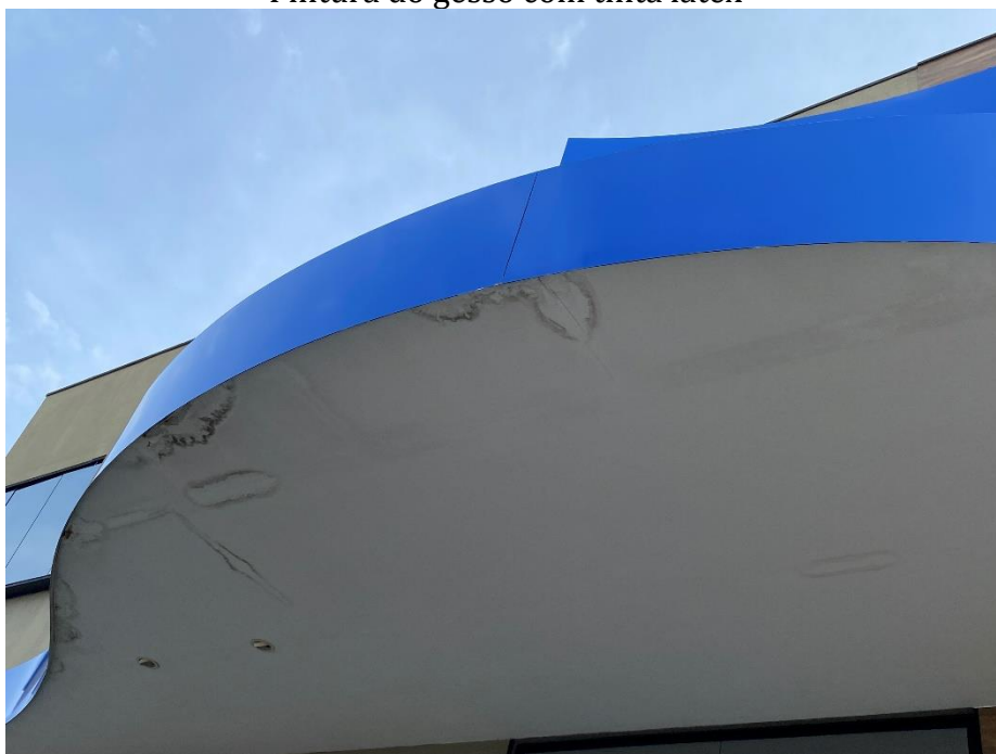
Remoção e aplicação de PU nas calhas superiores Pintura do gesso com tinta látex
