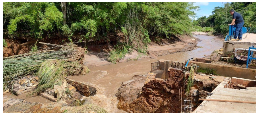
Figura 2 – Situação da Captação do Lajeado após rompimento da Barragem em dezembro de 2022. Fonte: SAAEDOCO, 2023.
