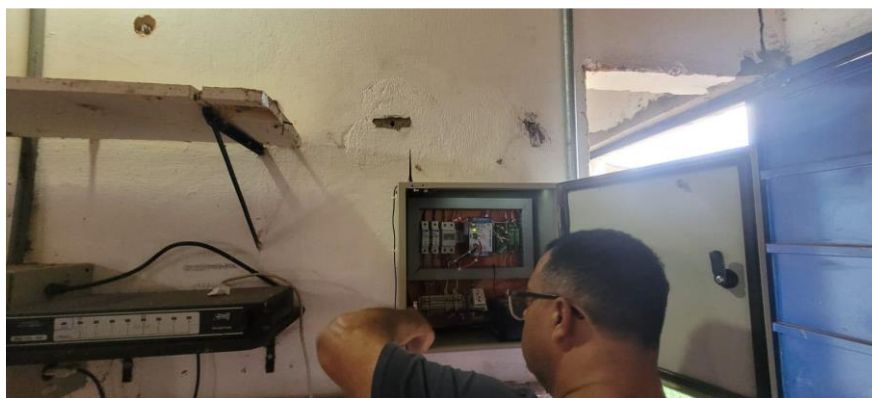
Foto 3 – Manutenção do painel elétrico do Reservatório R06 – Felipão. Fonte: SAAEDOCO, 2023.
