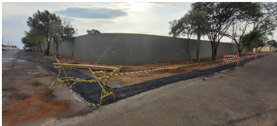
Fotos 1, 2 e 3 – Trecho remanejado de ferro fundido para DEFoFo. Fonte: SAAEDOCO, 2023.
