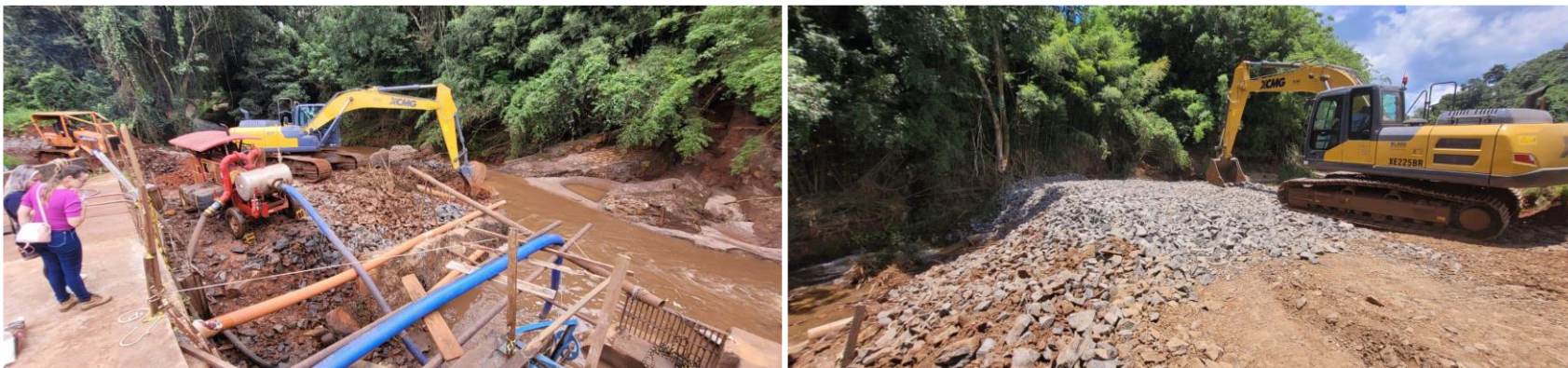
Fotos 3 e 4 – Obras emergenciais de recuperação e contenção da Barragem do Lajeado. Fonte: SAAEDOCO, 2023.
