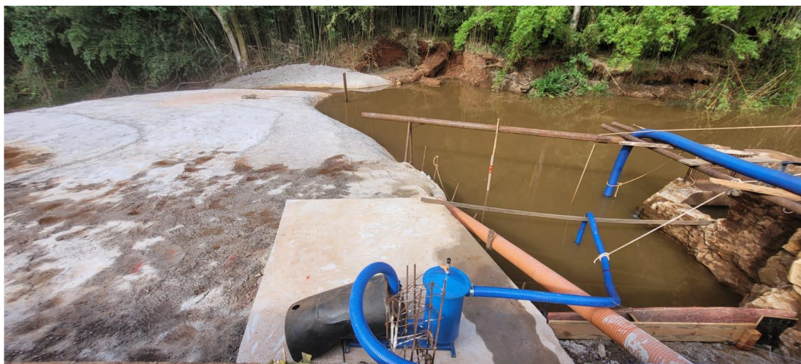
Fotos 5 – Situação atual da Barragem do Lajeado Fonte: SAAEDOCO, 2023.
