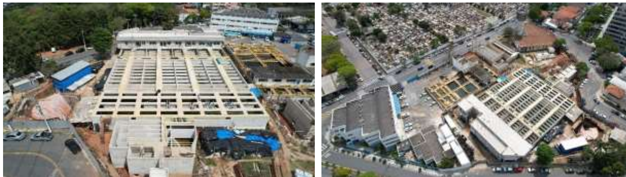
Figura TEC 3 – Fotos de drone da nova ETA Central.
