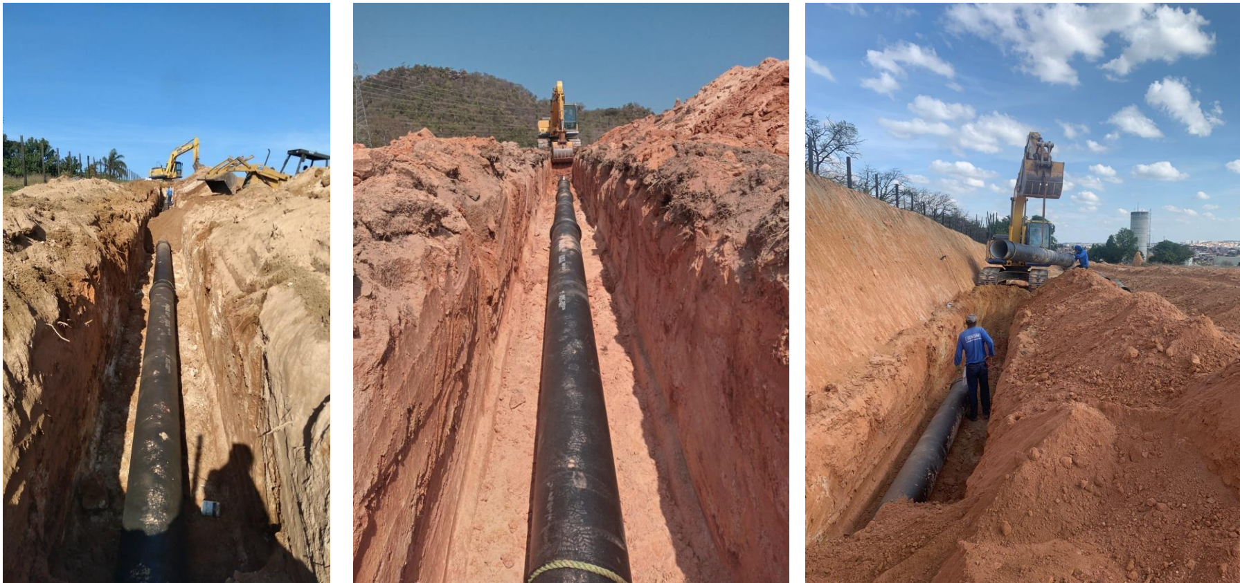
Figura TEC2: Instalação da segunda linha da Adutora de Captação de água bruta do Rio Atibaia – segundo trecho em execução. Fonte: fornecido pelo DAEV.
