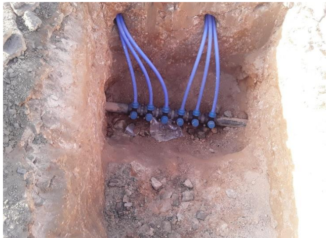
Figura TEC 4: Substituição de redes de abastecimento de água – Vila Santana e Jardim Pinheiros. Fonte: fornecido pelo DAEV.
