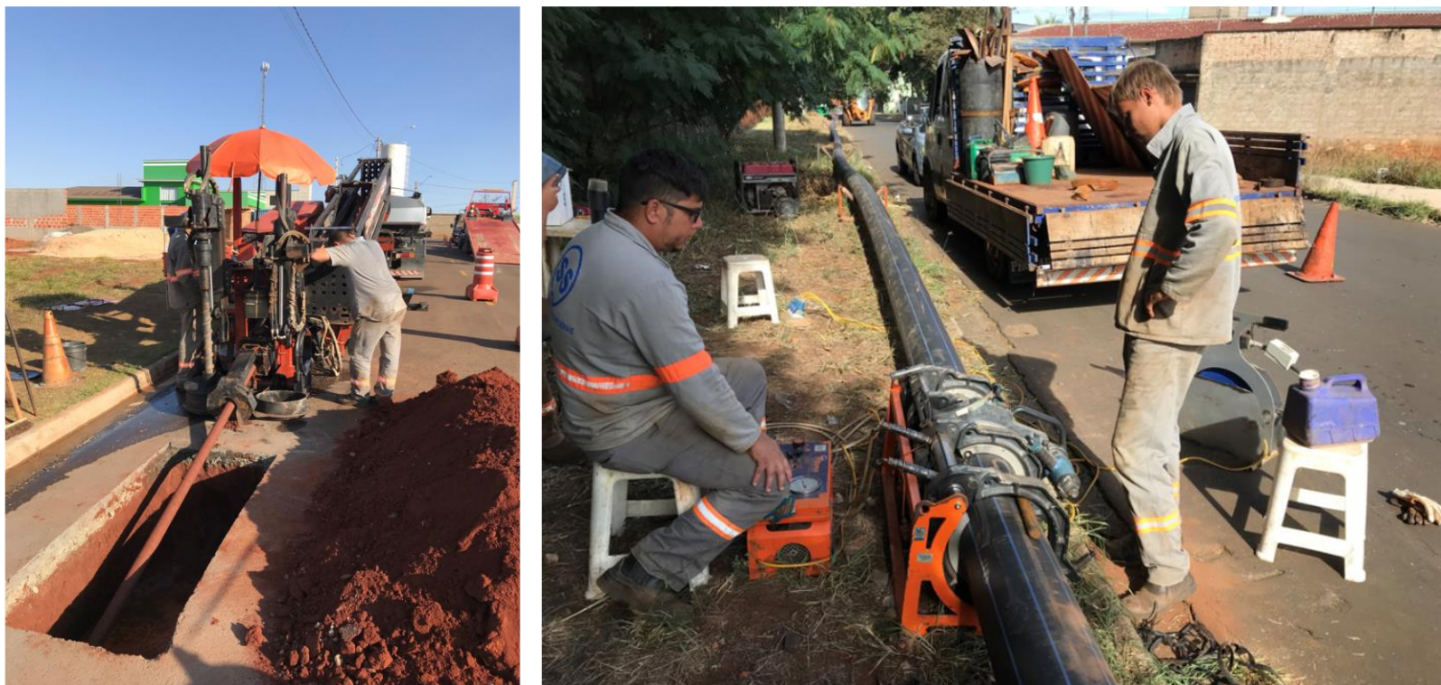
Fotos 1 e 2 – Substituição de redes na área central de Rio das Pedras (Fonte: Relatório de Acompanhamento SAAE RDP)
