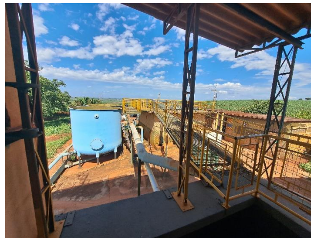
Fotos 2 – Novas unidades de filtração das ETAs 1
