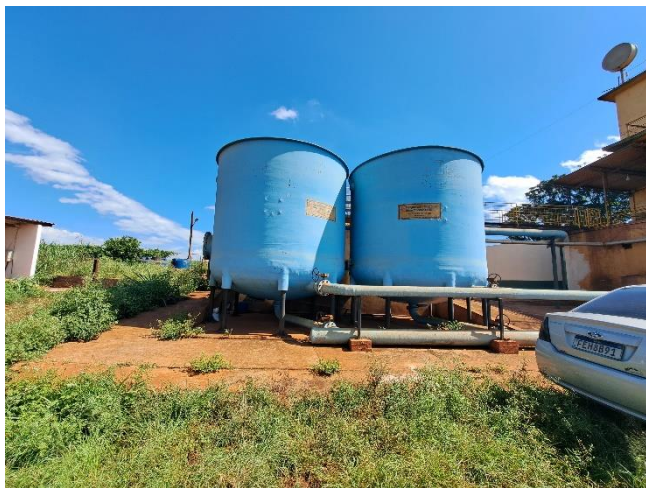
Fotos 1 – Novas unidades de filtração da ETA 1
