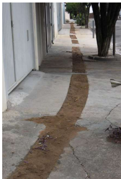
Figura TEC 4 – Substituição de redes de ferro fundido e galvanizado na região Sul – Bairro Cruzeiro do Sul. Fonte: SAAE, 2022
