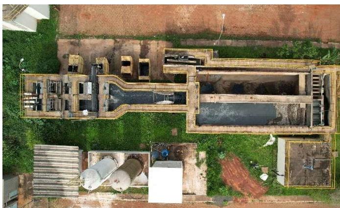
Figura TEC 5 – Reforma do removedor de areia da ETE Monjolinho
