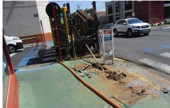
Figura TEC 3 – Substituição de redes de ferro fundido e galvanizado na região Norte-Rua Dona Alexandrina (Fonte: SAAE,2022)
