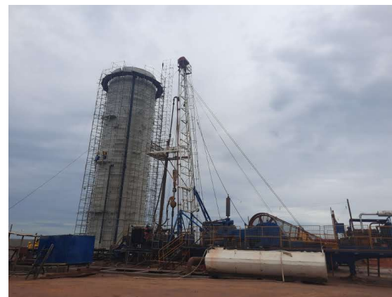
Figura TEC 8 – Construção do centro de produção, reservação e distribuição Concretiza
