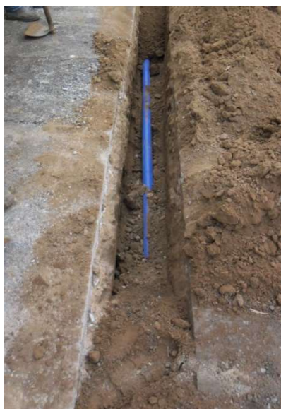
Figura TEC 4 – Substituição de redes de ferro fundido e galvanizado na região Sul – Bairro Cruzeiro do Sul. Fonte: SAAE, 2022
