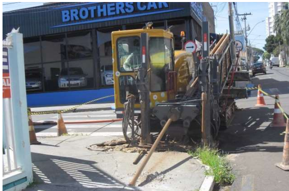
Figura TEC 3 – Substituição de redes de ferro fundido e galvanizado na região Norte-Rua Dona Alexandrina (Fonte: SAAE,2022)
