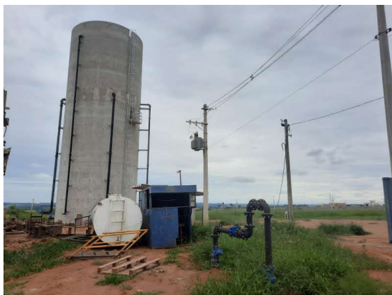
Figura TEC 7 – Construção do centro de produção, reservação e distribuição Villeneuve
