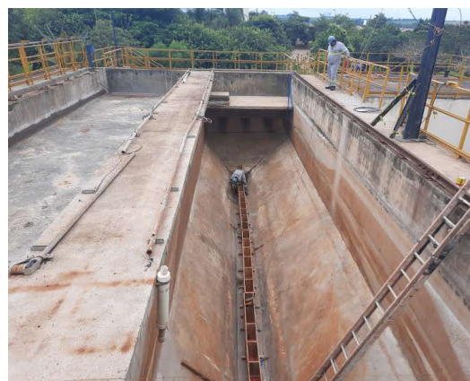
Figura TEC 5 – Reforma do removedor de areia da ETE Monjolinho
